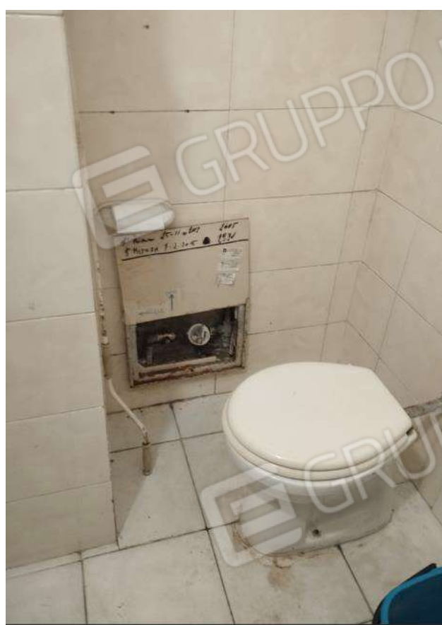
Foto 8 bagno di servizio
