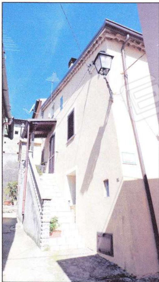
Angolo principale sud-est: scala esterna
