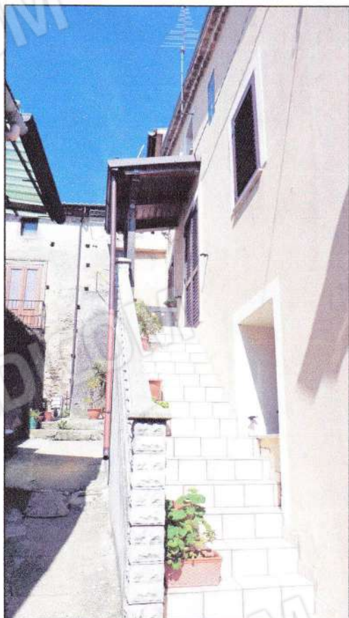
Lato sud-est: scala esterna con tettoia
