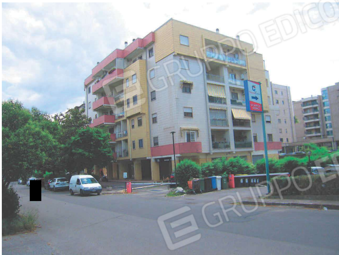
Foto n° 1 e 2 - Esterno del fabbricato
