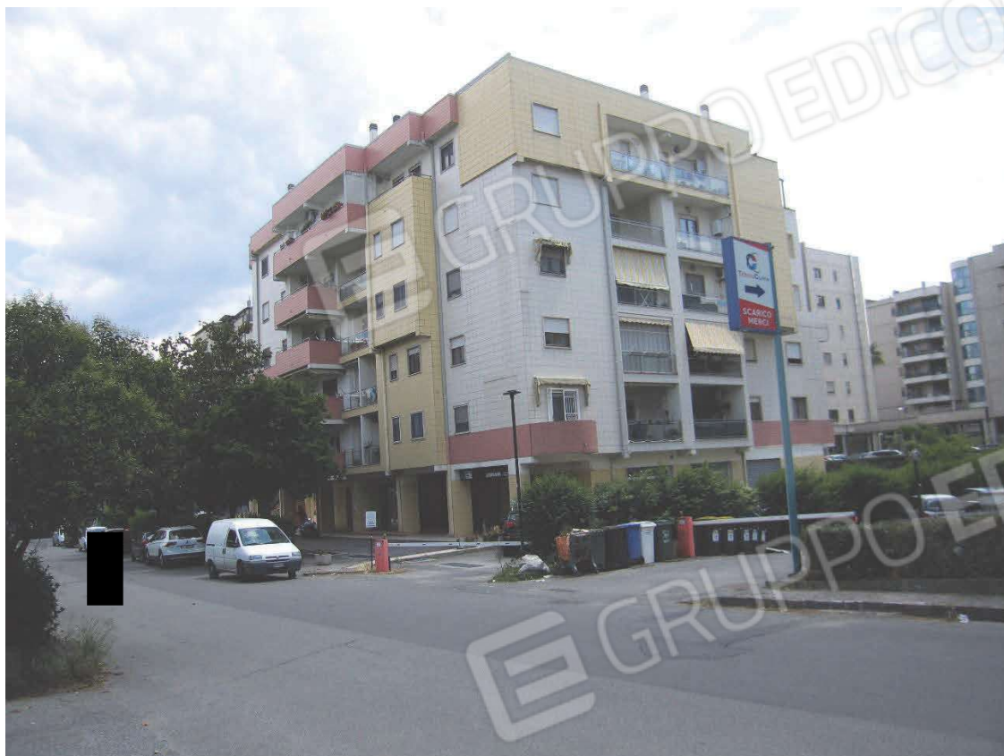
Foto n° 1 e 2 - Esterno del fabbricato
