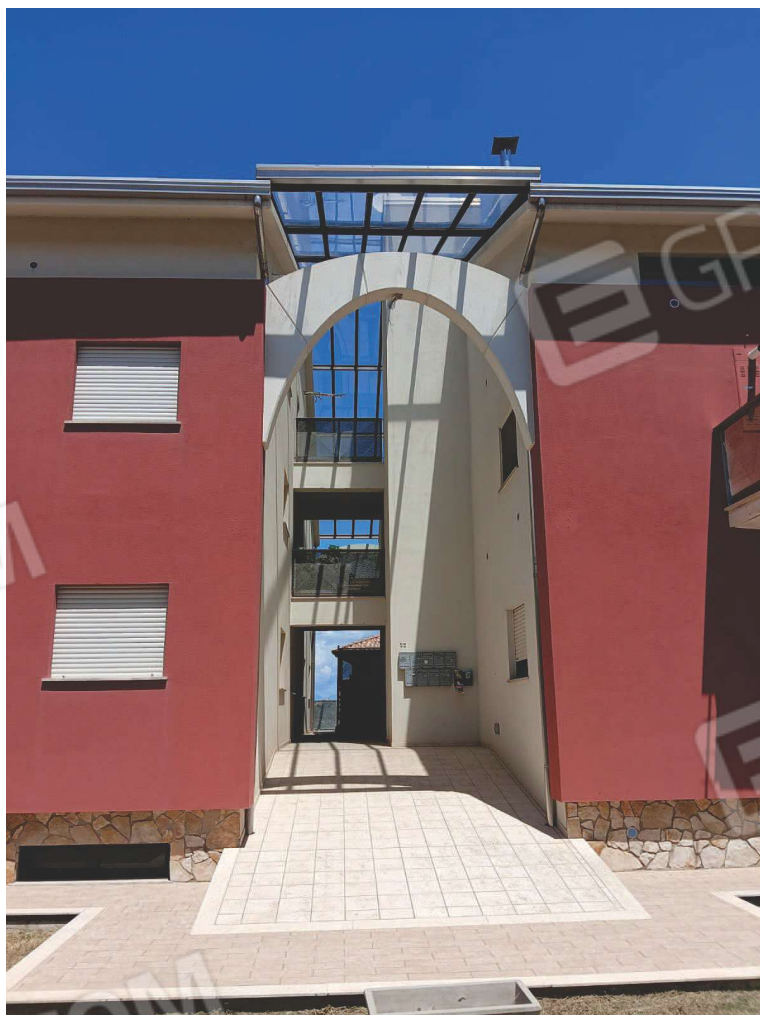
Foto n°2: Ingresso al fabbricato
