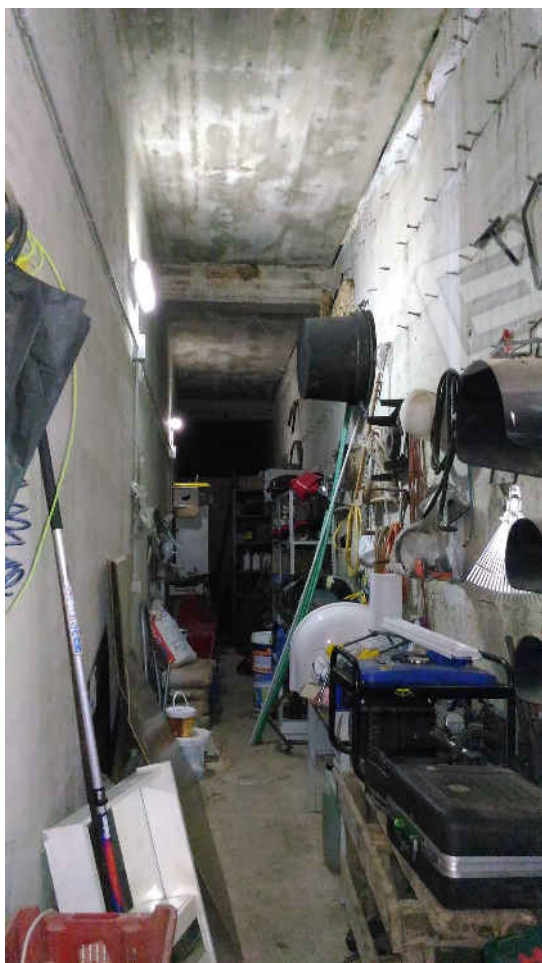
intercapedine, lato sud-ovest, usata come ripostiglio
