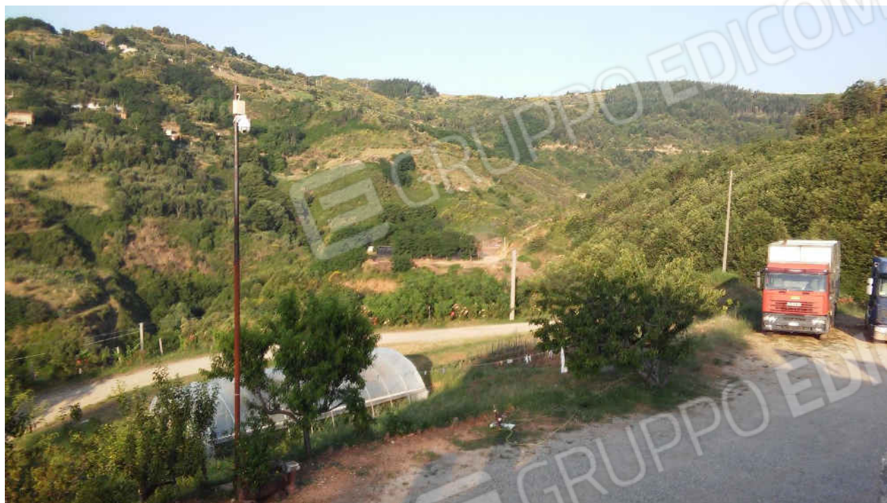
zona est, strada di accesso vicinanza capannone
