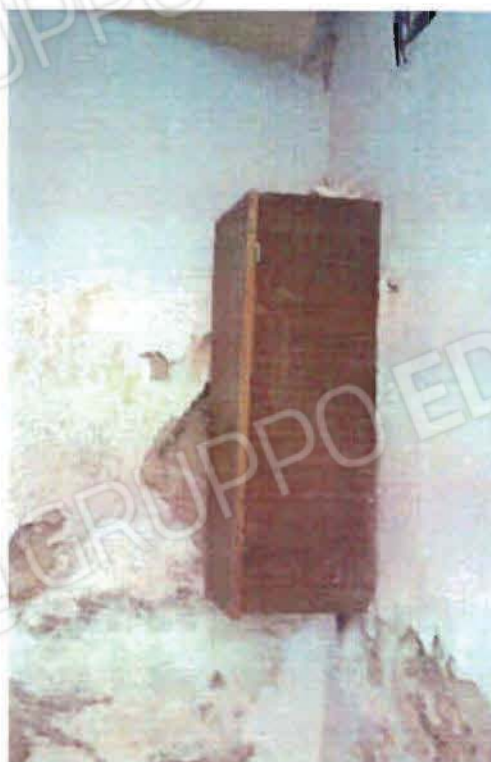
foto n°12_Particolari interno stanza n°1_PT
