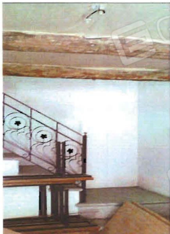
foto n°11_Particolari interno stanza n°1_PT
