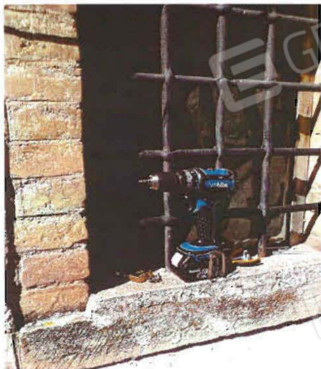
foto n°39 _Particolare chiusura portoncino ingresso
