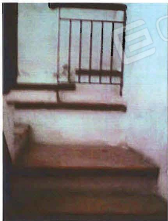
foto n°19_Particolare interno vano scala_PT
