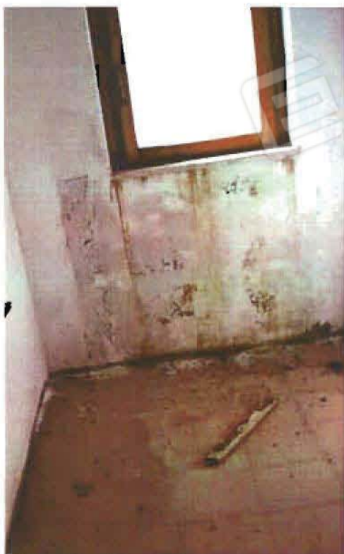
foto n°31_Particolari ripostiglio 3P
