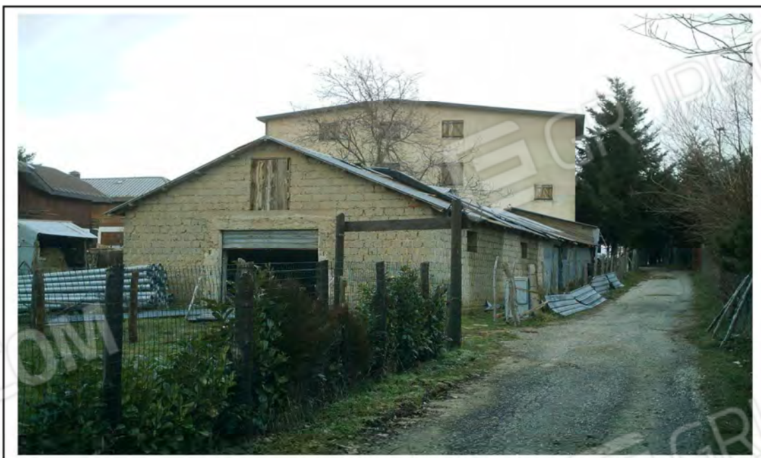
Foto n. 10 – Veduta fabbricato di muratura e retrostante di legno
