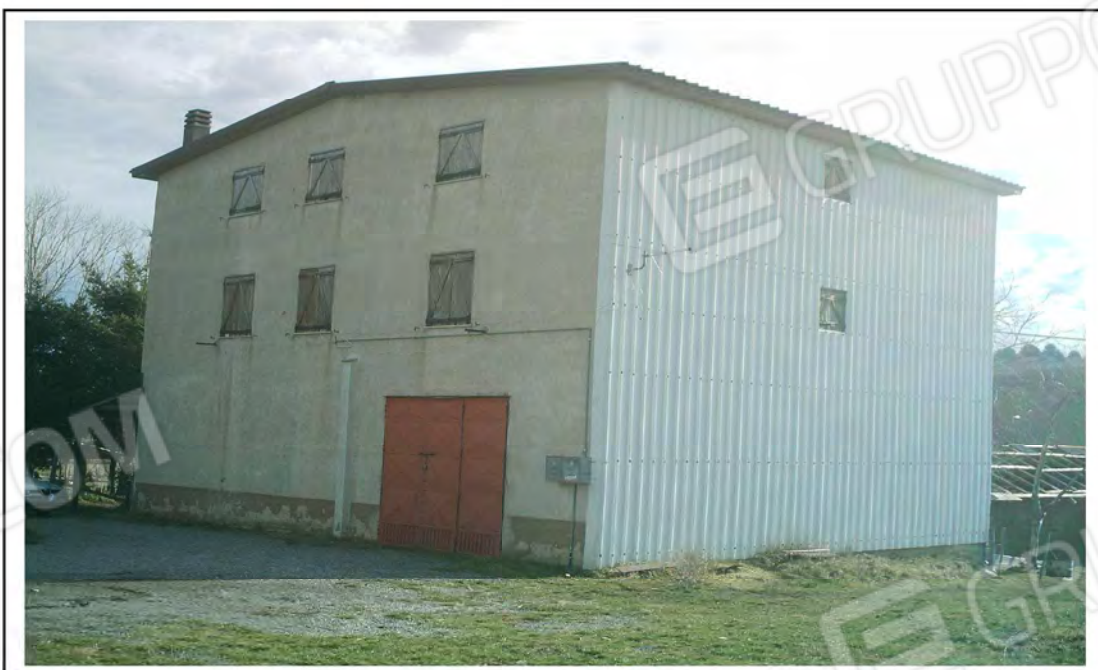
Foto n. 6 – Veduta Fabbricato p.lla 498
