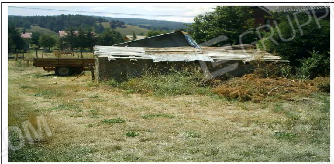
Foto n. 15 – Manufatti da demolire
