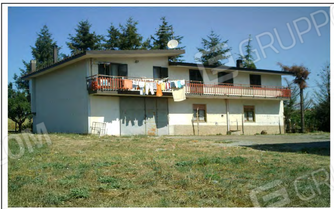
Foto n. 8 – Veduta OVEST-SUD Fabbricato p.lla 497
