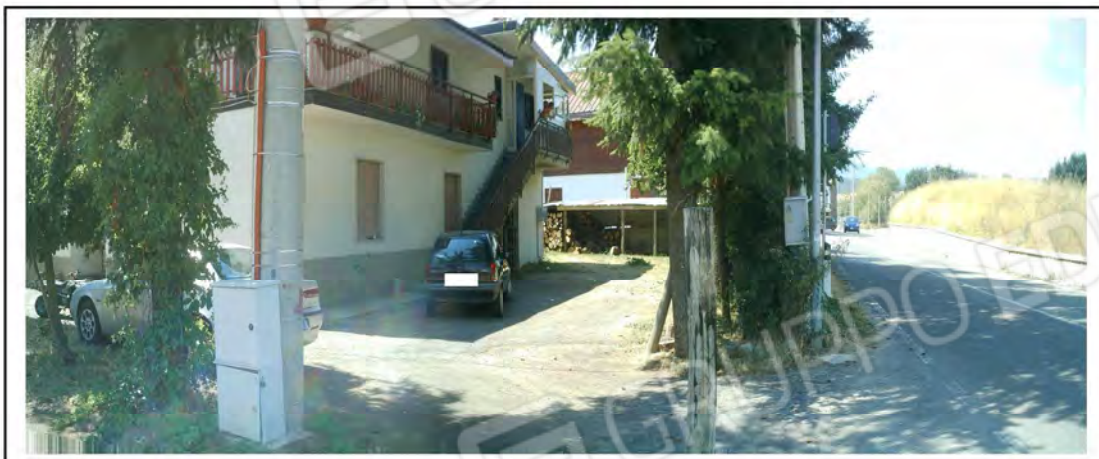
Foto n. 7 – Veduta EST-NORD-OVEST Fabbricato p.lla 497
