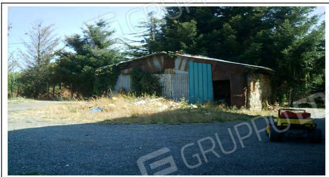
Foto n. 14 – Manufatti da demolire
