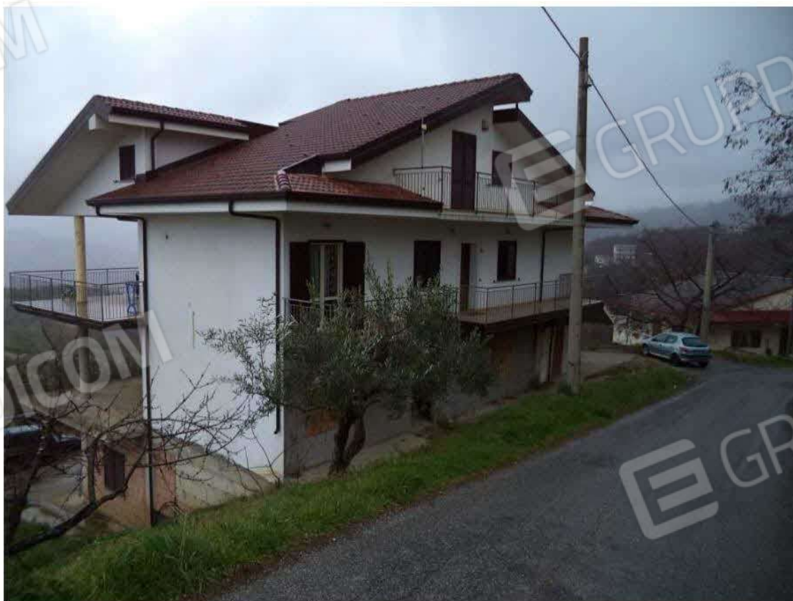
Fabbricato in oggetto e prospetto 1 e 4
