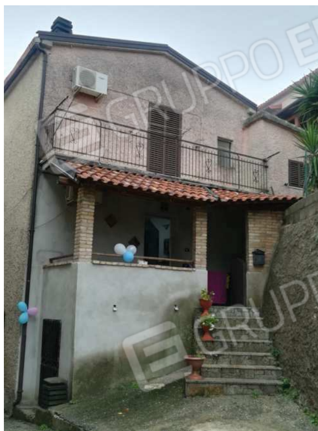
Foto 23 – P.I. Ingresso lato Nord
