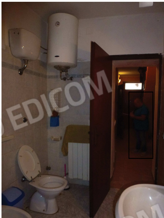
Foto 14 – P.T. locale WC
