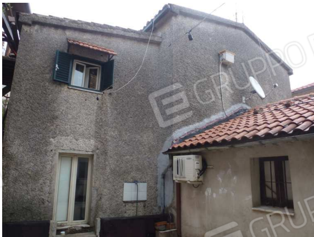
Foto 5 - Prospetto lato Sud (retro)
