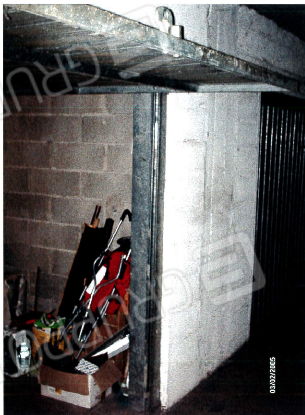
Foglio 39 p.la 165 sub 201 esterno
