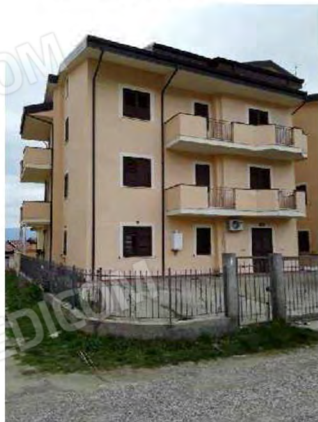
Foto n.7 vista prospetto ovest
