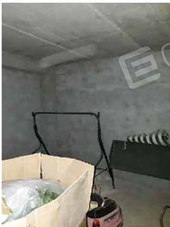
Foto n.5 interno locale cantina
