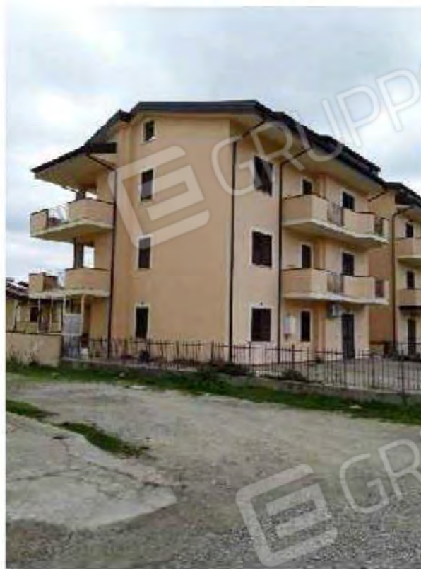
Foto n.8 vista prospetto nord
