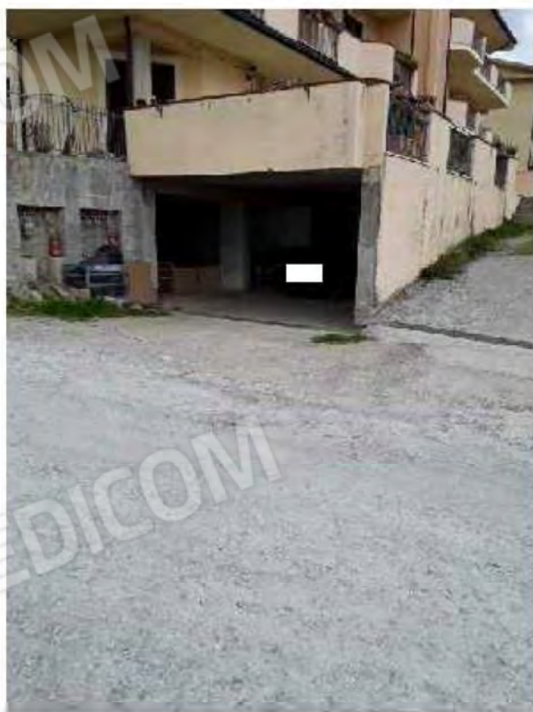
Foto n.7 vista generale ingresso garages
