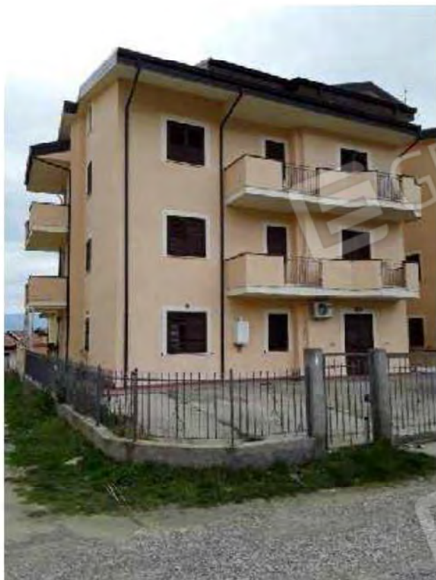
Foto n.9 vista prospetto ovest
