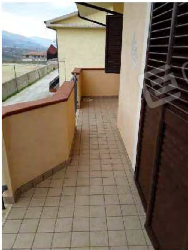
Foto n.9 Piano secondo-terrazzo foglio n 50 p.lla 466 sub 6
