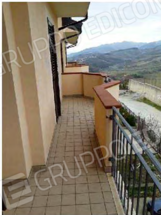
Foto n.10 Piano secondo-terrazzo foglio n 50 p.lla 466 sub 6
