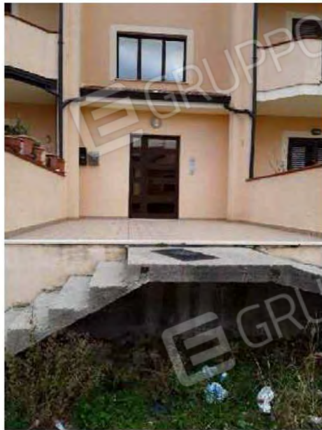
Foto n.16 ingresso principale- foglio n 50 p.lla 466 sub 15
