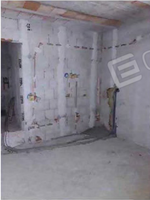
Foto n.5 Piano secondo-cucina foglio n 50 p.lla 466 sub 6
