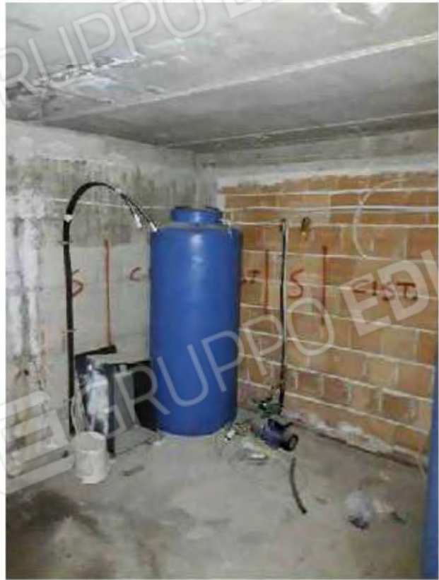
Foto n.2 locale tecnico foglio n 50 p.lla 466 sub 16
