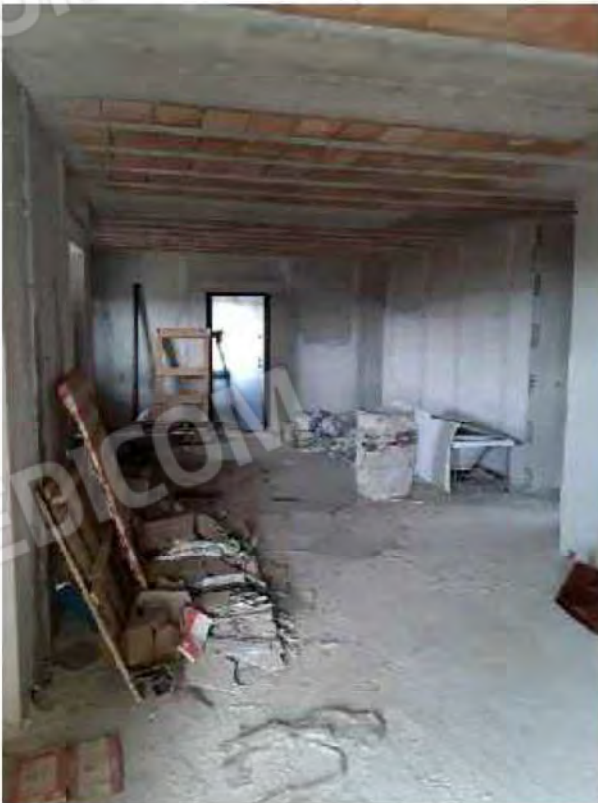
Foto n.3 Piano primo-ingresso foglio n 50 p.lla 466 sub 4
