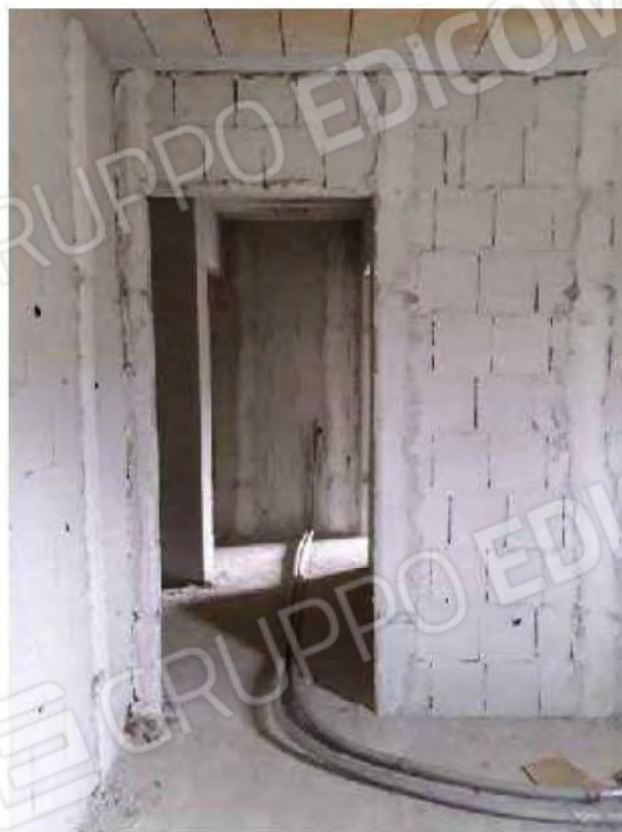
Foto n.6 Piano primo-disimpegno foglio n 50 p.Ila 466 sub 4
