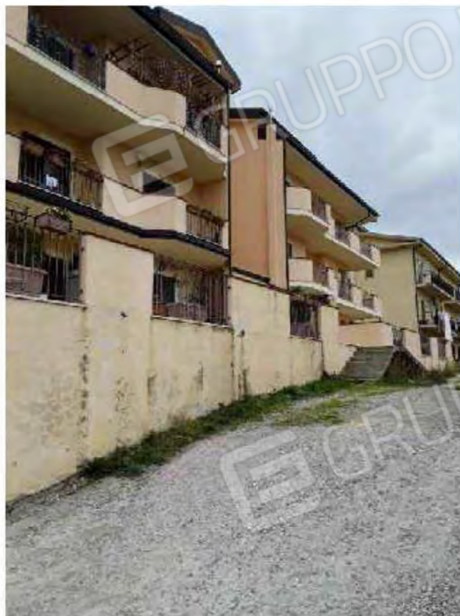
Foto n.16 vista prospetto est
