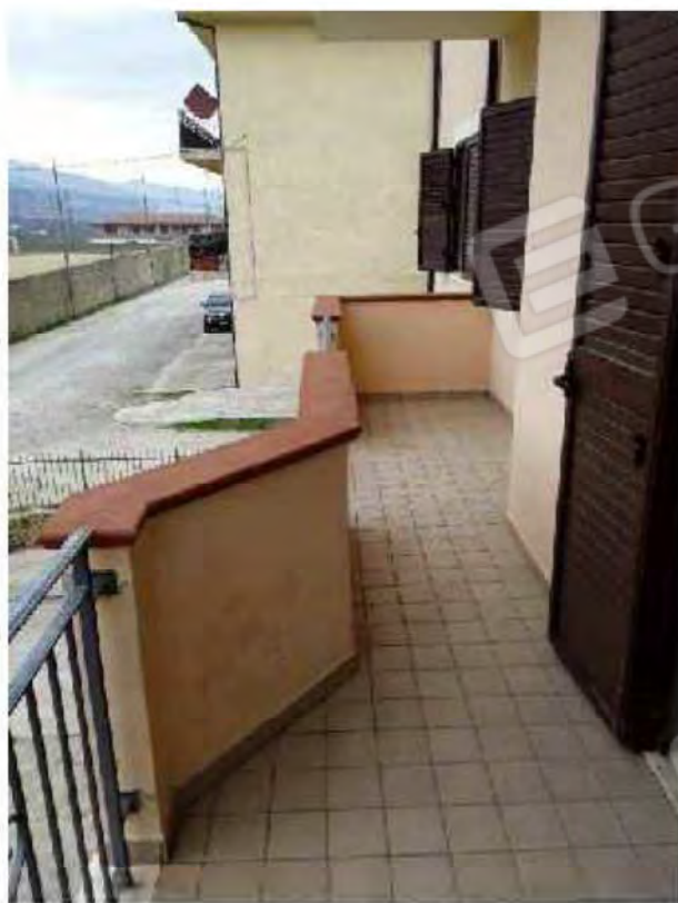
Foto n.9 Piano primo-terrazzo foglio n 50 p.lla 466 sub 4
