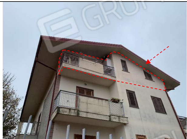
Vista dell’immobile dalla corte interna – fronte NORD
