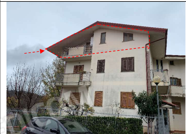
Vista dell’immobile dalla corte interna – fronte NORD
