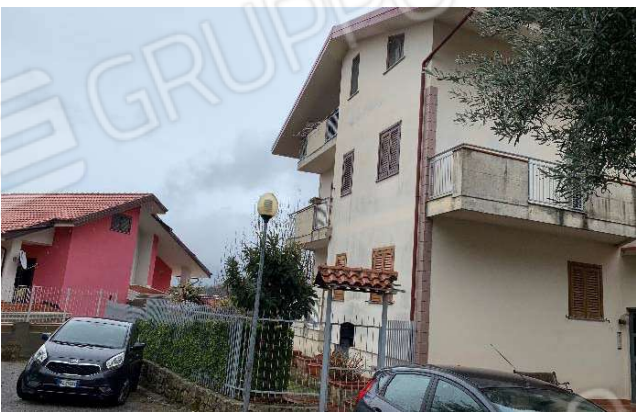
Vista dell’immobile dalla corte interna – fronte NORD
