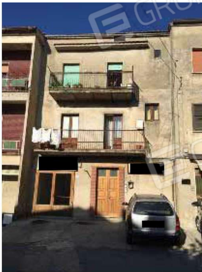
Prospetto su via Principe di Piemonte
