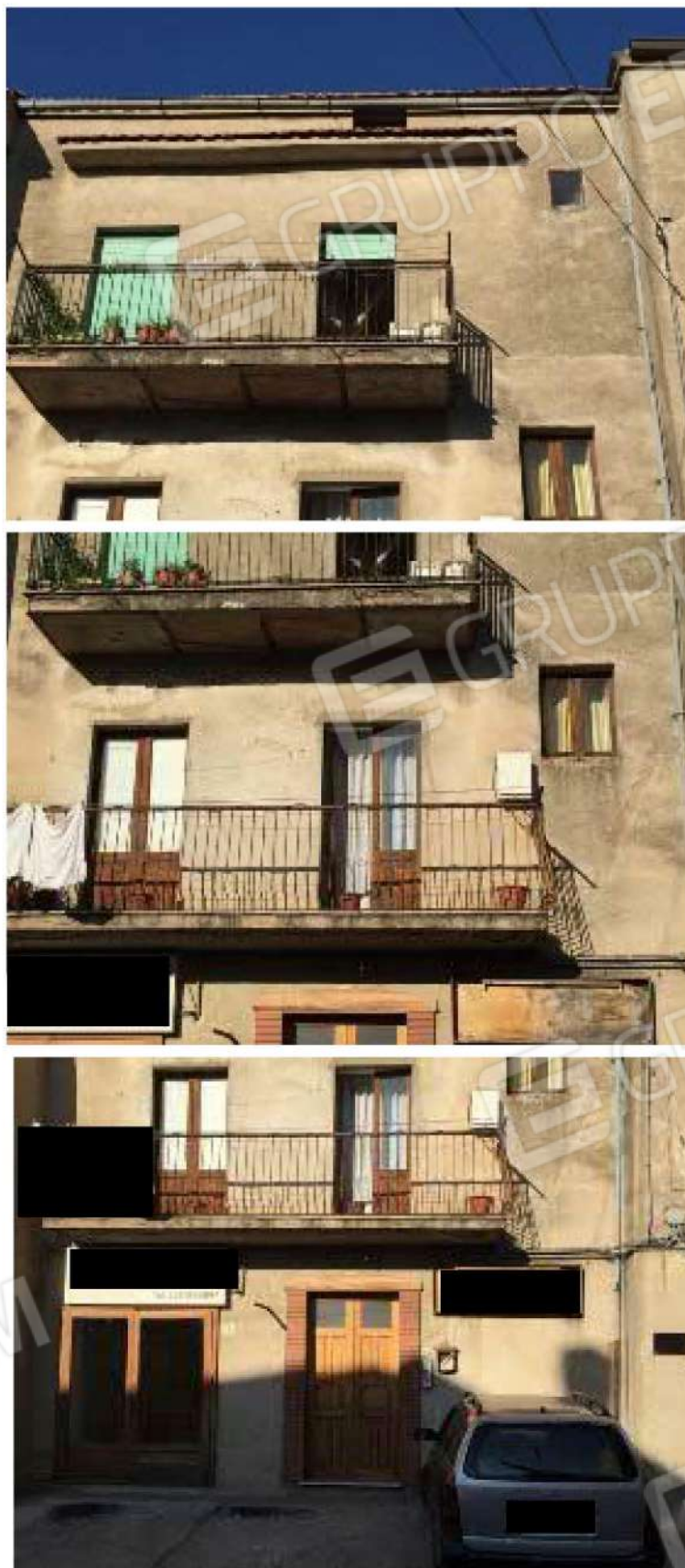
Prospetto su via Principe di Piemonte
