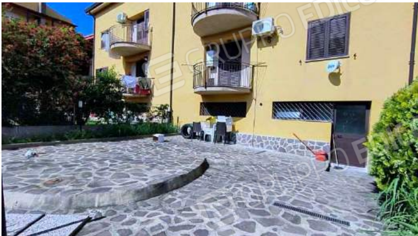
Foto 33 - Ingresso esterno al laboratorio al piano seminterrato dalla corte esclusiva.
