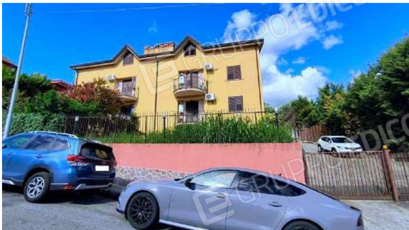
Foto 1 - Fabbricato in San Pietro in Guarano (CS), località Padula, Via Due Forni n.39.
