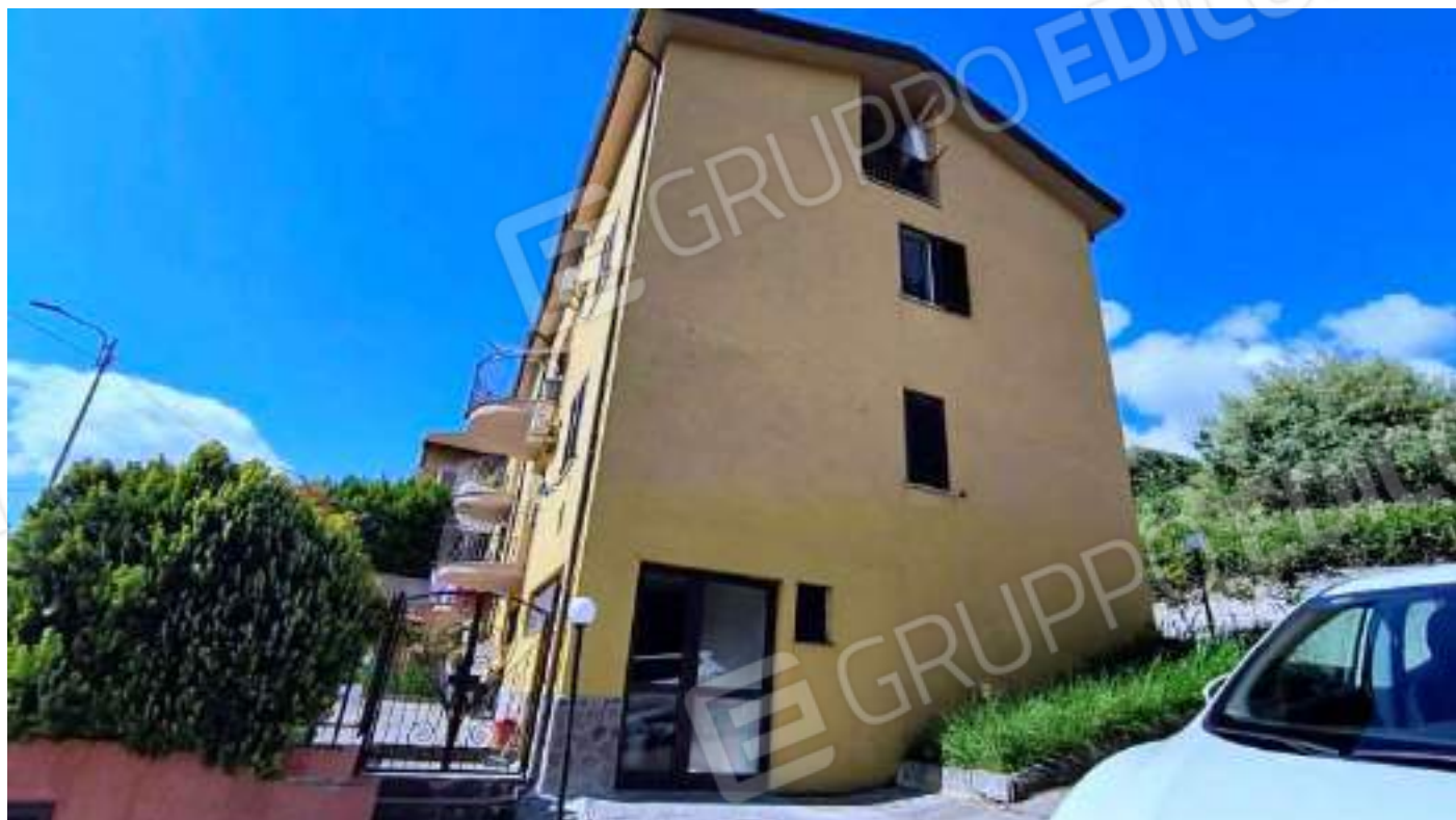
Foto 3 - Fabbricato in San Pietro in Guarano (CS), località Padula, Via Due Forni n.39. Prospetto laterale.
