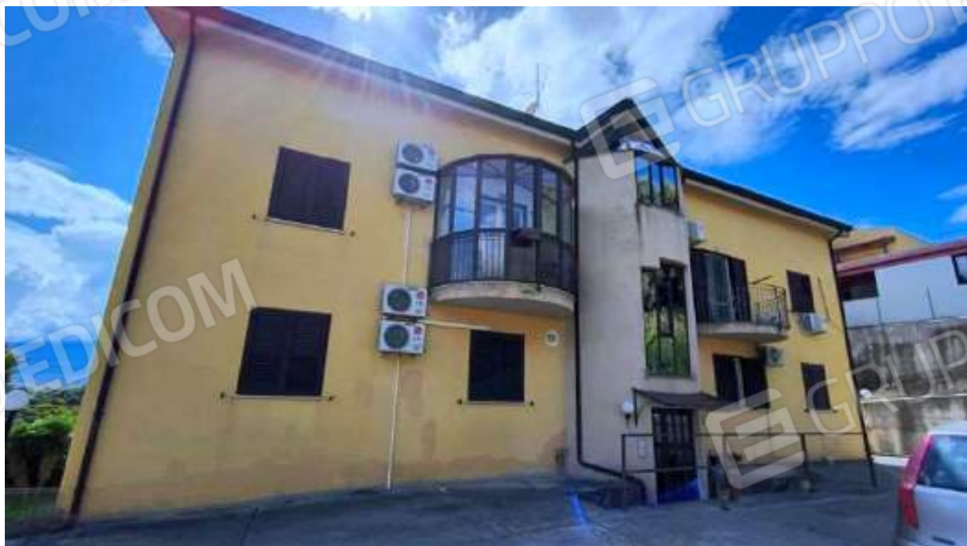
Foto 4 - Fabbricato in San Pietro in Guarano (CS), località Padula, Via Due Forni n.39. Prospetto posteriore.
