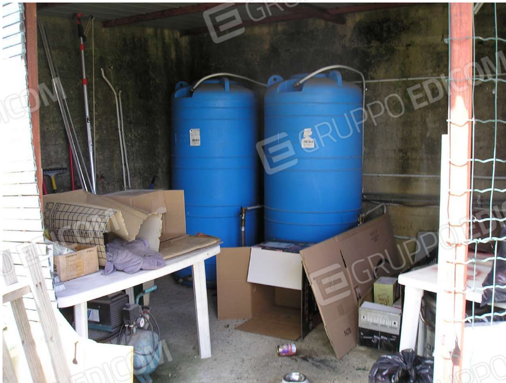
Foto n. 25: Serbatoio autoclave
