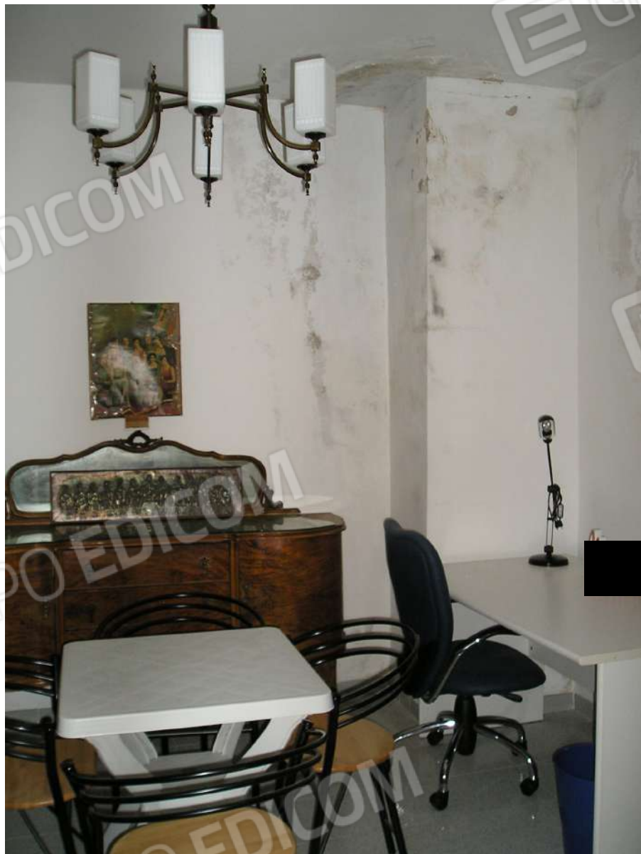
Foto n. 27: Vano pluriuso con presenza di infiltrazioni
