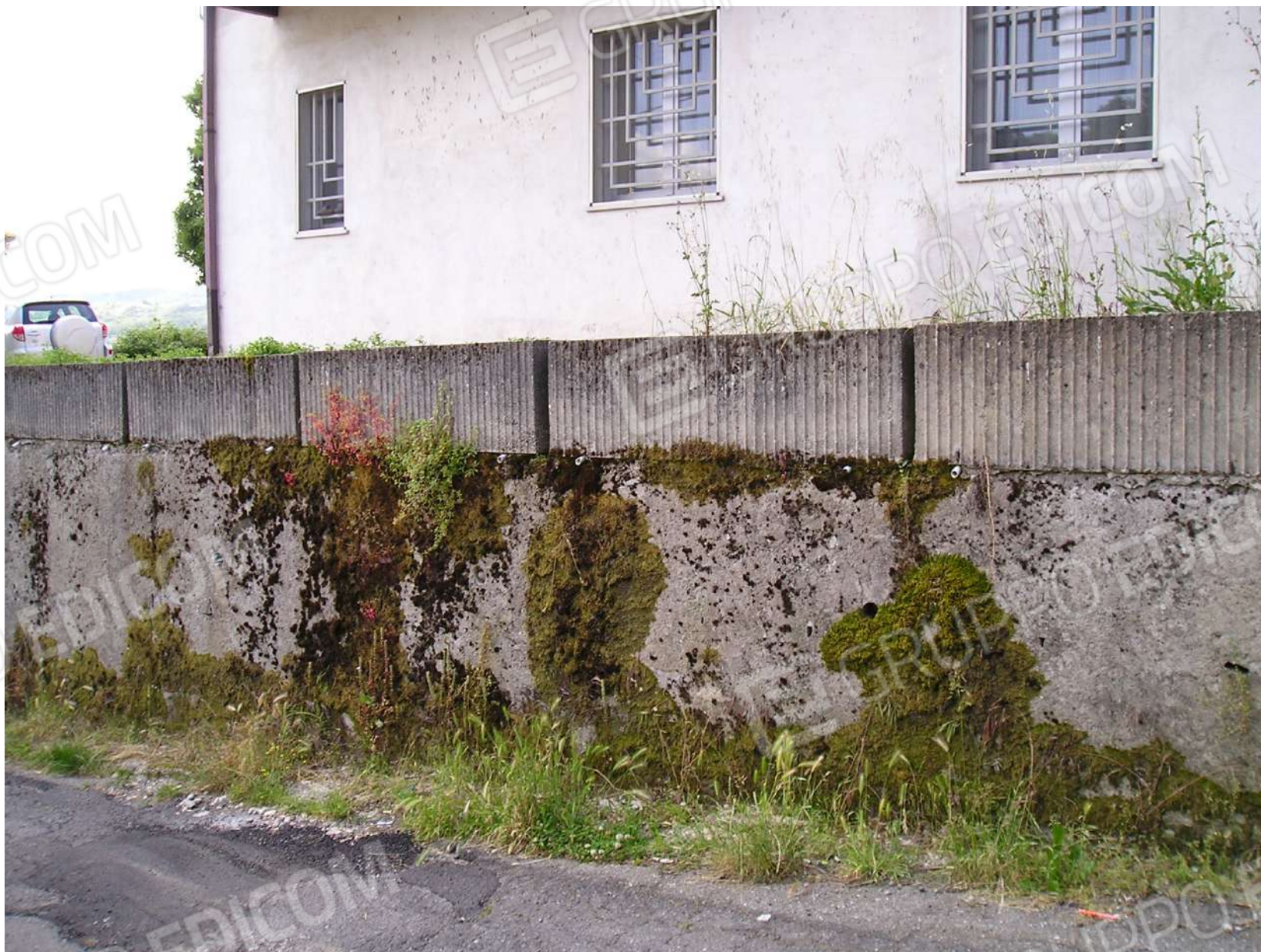
Foto n. 7: Particolare muro a valle del fabbricato
