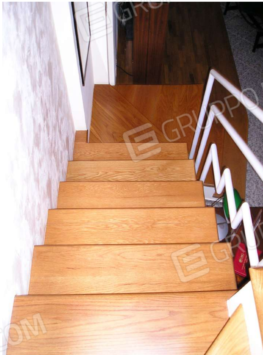
Foto n. 22: Particolare scala interna di collegamento
