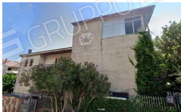
Vista dell'immobile – fronte OVEST
