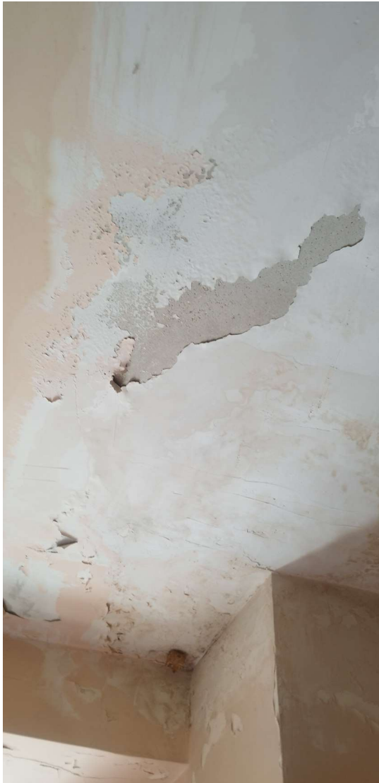
Foto n°8: – Particolare del soffitto del bagno dell'appartamento posto al piano 1° sottostante l'u.i. oggetto di esecuzione dove è presente lo scrostamento della tinteggiatura; la zona, al tatto è risultata completamente asciutta.
