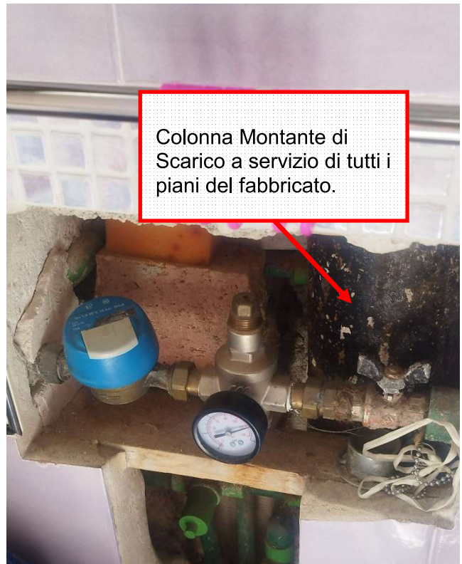
Foto n°5: – Tratteggio in Verde foto n°4 Particolare interno muratura nella quale è posto il misuratore idrico e la colonna montante a servizio di tutti i piani del fabbricato;
