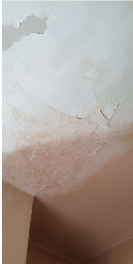
Foto n°8: – Particolare del soffitto del bagno dell'appartamento posto al piano 1° sottostante l'u.i. oggetto di esecuzione dove è presente lo scrostamento della tinteggiatura; la zona, al tatto è risultata completamente asciutta.
