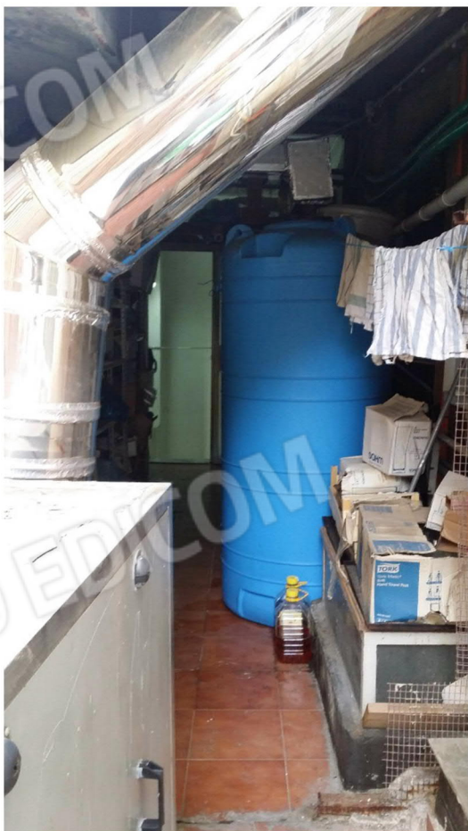
Foto n. 28 – terrazzo parte coperta
