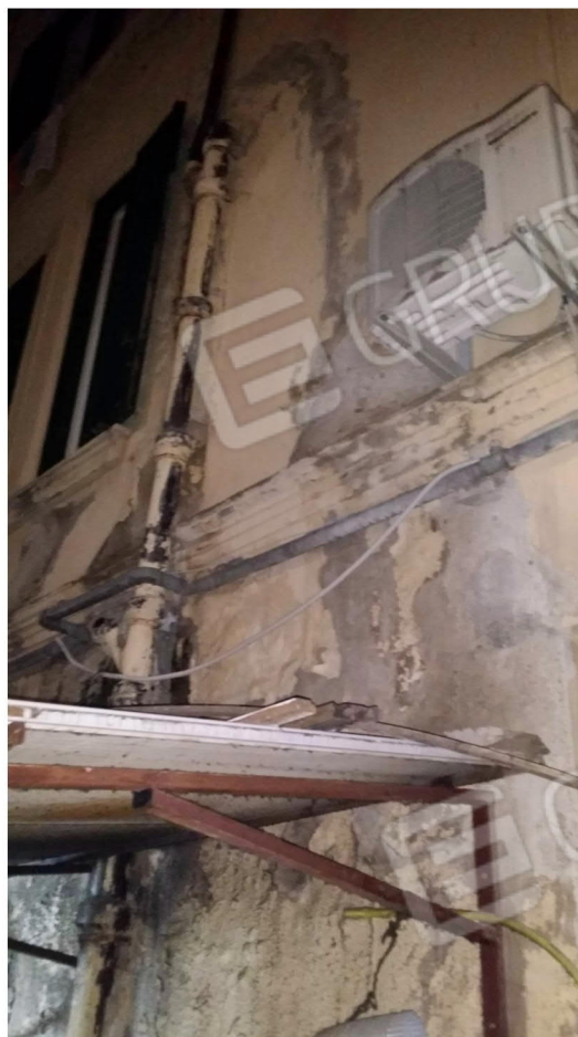
Foto n. 32 – terrazzo infiltrazione
