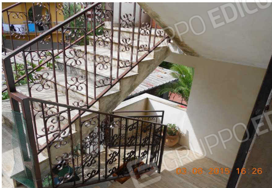
Foto 25— Scala esterna lato posteriore
