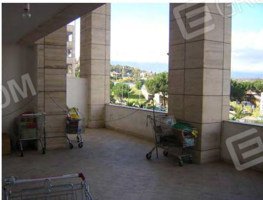
Foto 14. Appartamento, terrazzo Nord, lato Ovest.
