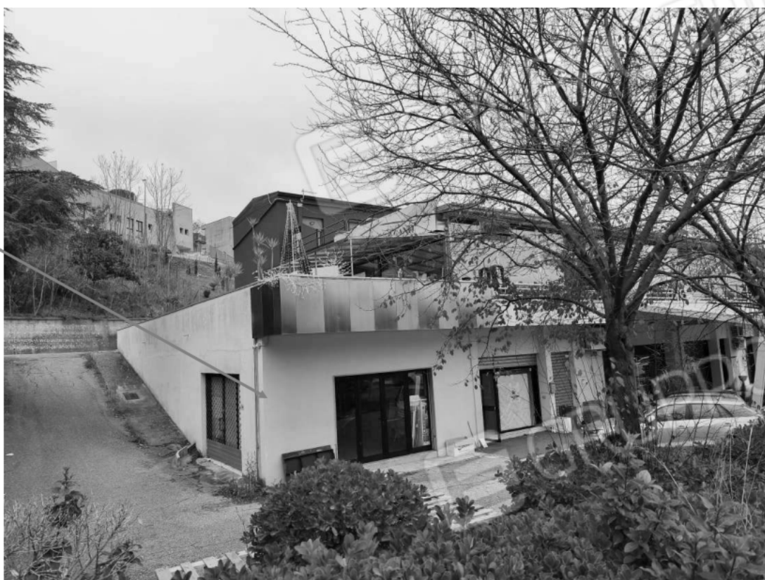
Foto n. 6: Immobile pignorato – visibili i quattro accessi
