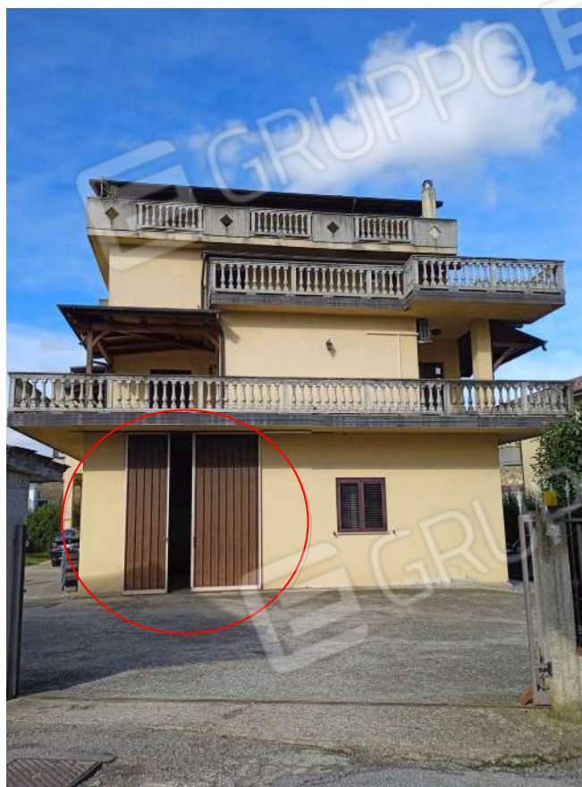
Foto n°1: Particolare evidenziato dell'ingresso esterno al magazzino
