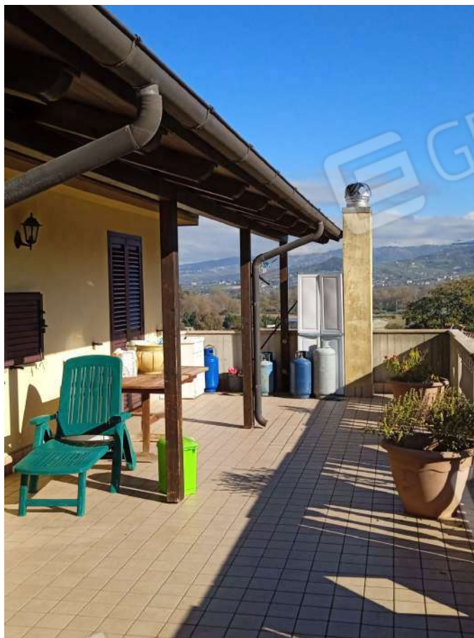
Foto n°9: Particolare altro terrazzo esterno
