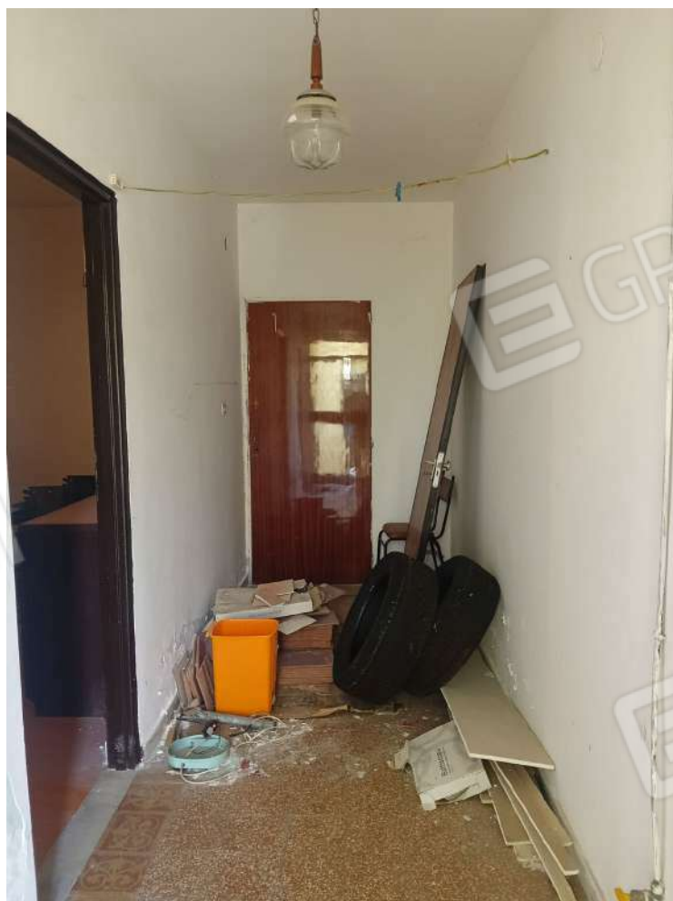
Foto n°9: Particolare dell'interno – corridoio d'ingresso
