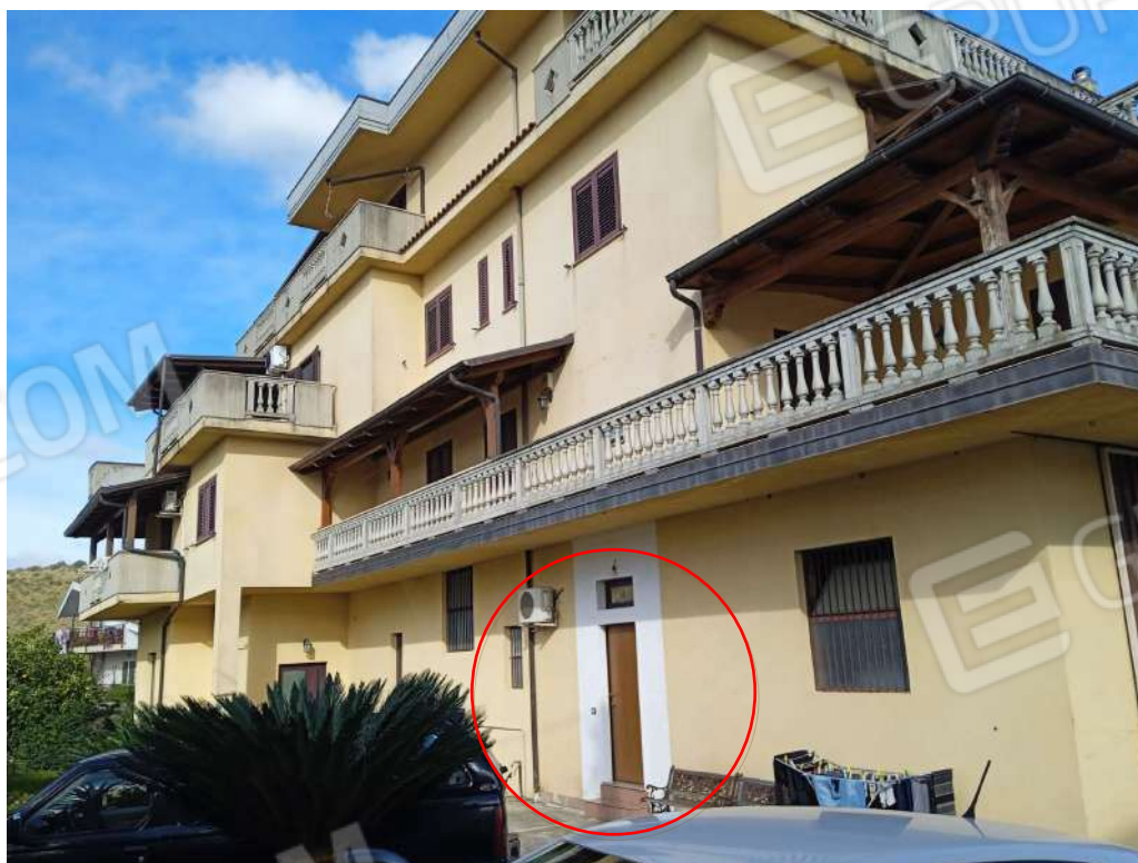
Foto n°2: Altro ingresso esterno al magazzino
