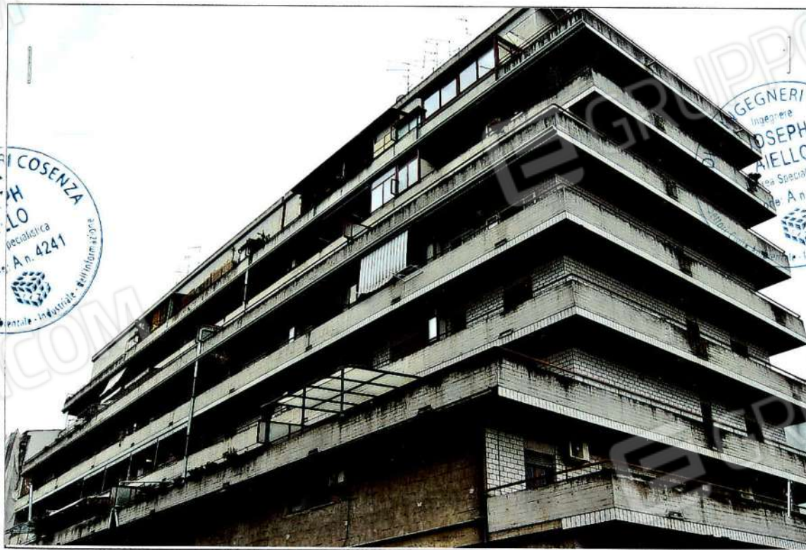
Fotografia 4 – Fabbricato foglio 3, particella 451 (lato Est)
