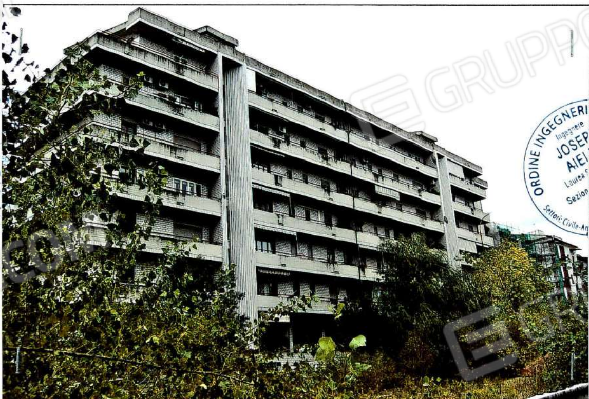
Fotografia 2 – Fabbricato foglio 3, particella 451 (lato Ovest)
