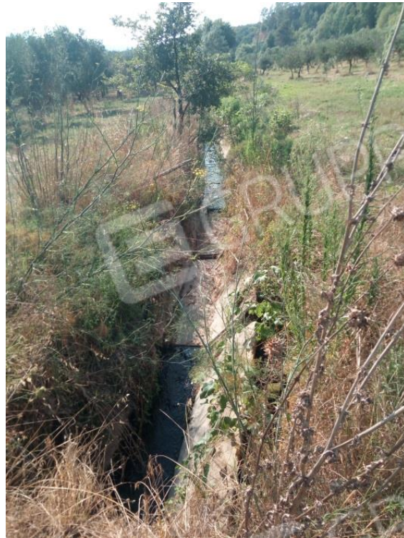
Foto n. 14 – Canale di scolo
