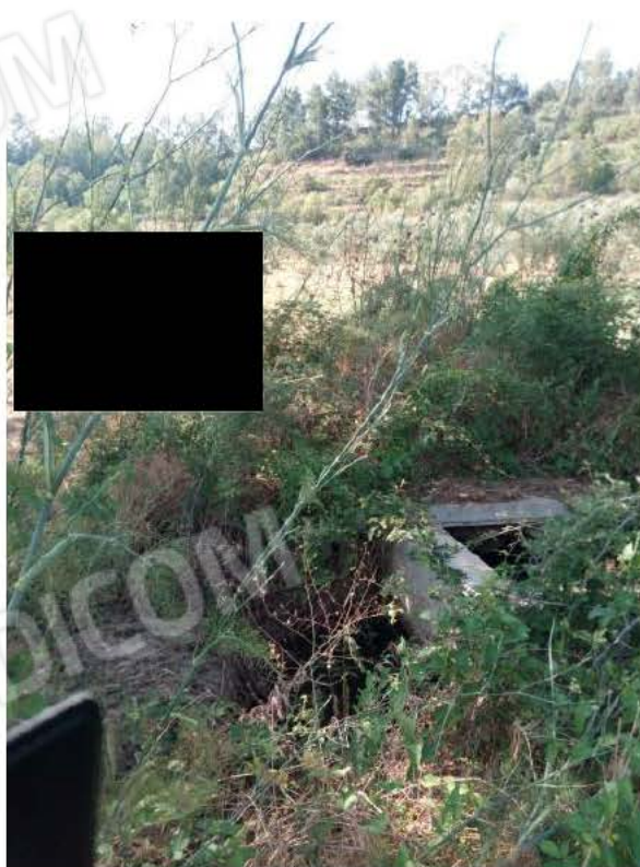
Foto n. 17 – Canale di scolo, nella zona d'accesso
