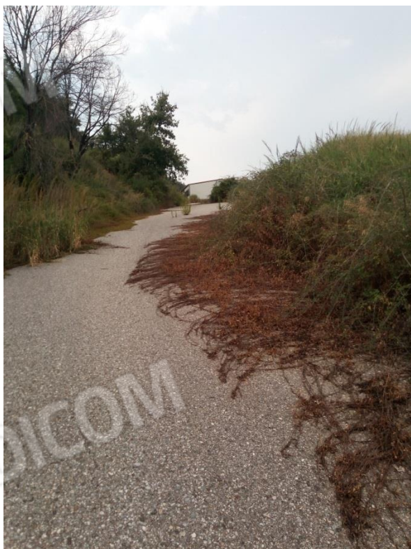
Foto n. 8 – La strada dopo il cancello
