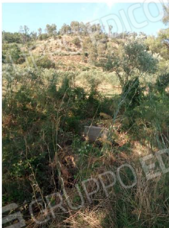
Foto n. 16 – Canale di scolo, nella zona d'accesso
