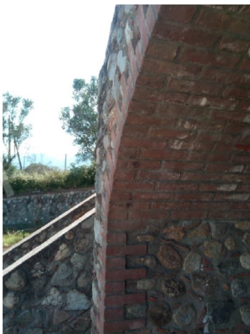
Foto n. 17 – Ingresso al p. terra, verso ovest
