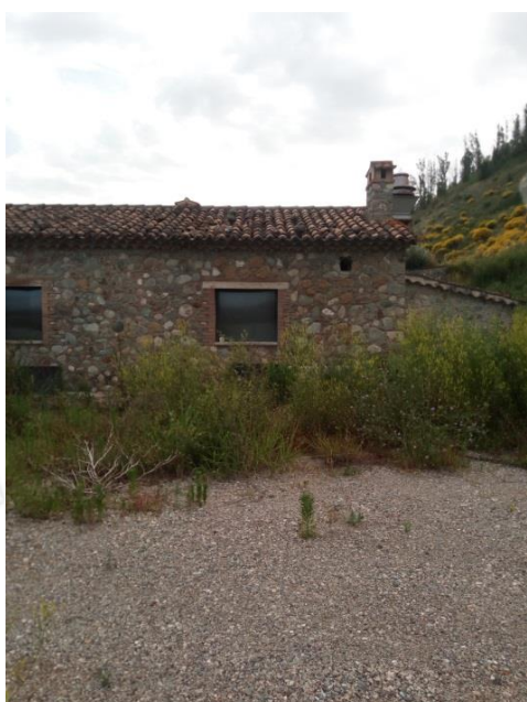
Foto n. 8 – Fabbricato, lato est
