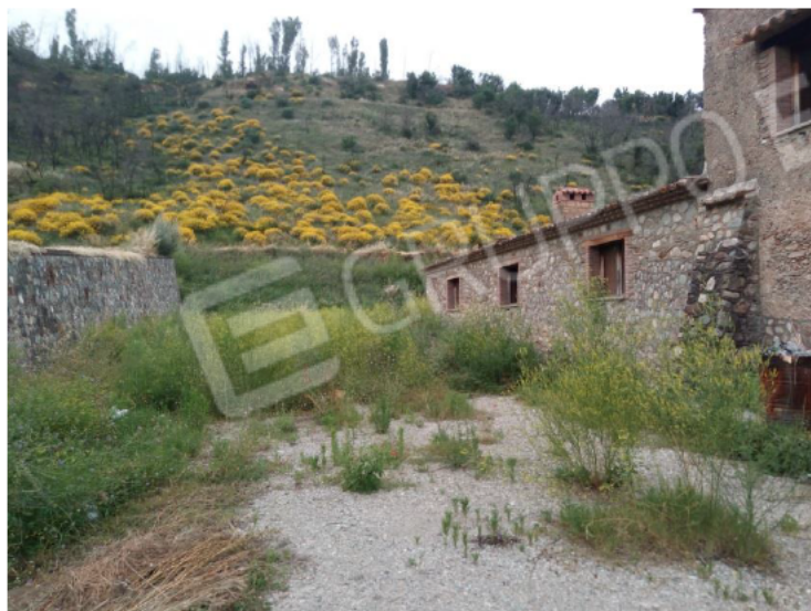
Foto n. 11 – Fabbricato e corte, lato ovest
