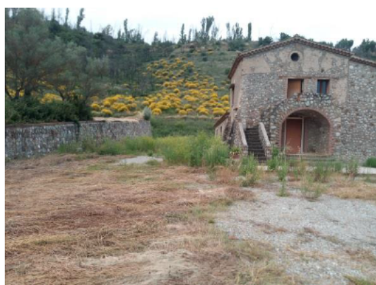
Foto n. 3 – Corte da sud
