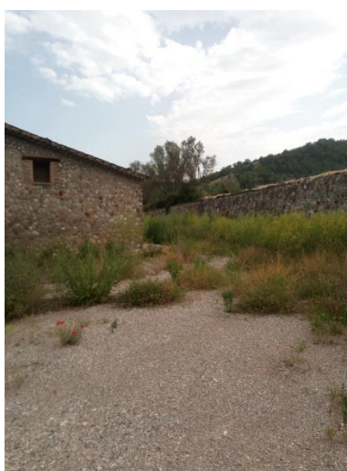
Foto n. 10 – Fabbricato, lato nord-ovest
