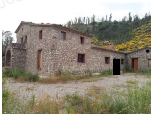
Foto n. 5 – Fabbricato, lato est
