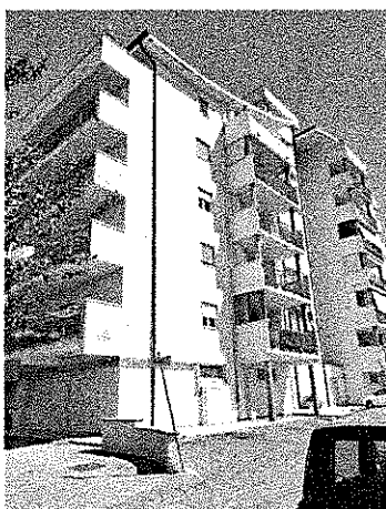
Fig. 4- prospetto principale a sud
