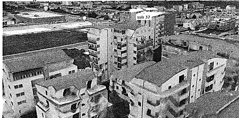
Fig.3 prospetti nord ed est del fabbricato ed individuazione dell'appartamento
