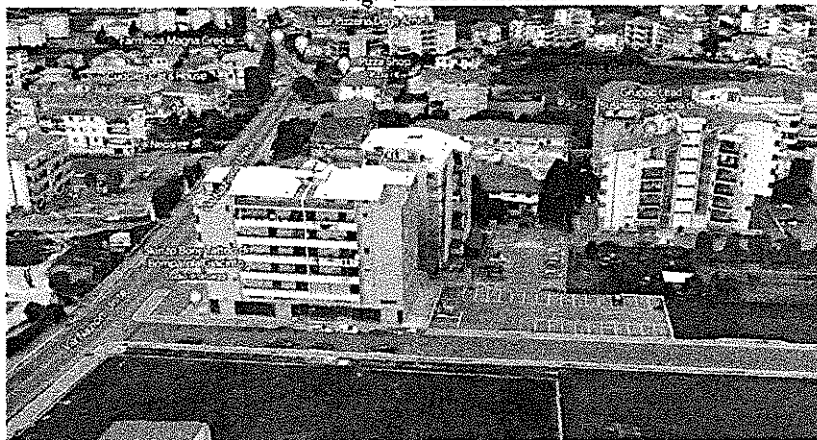
Fig.2 individuazione del fabbricato Greco, prospetto principale sud
