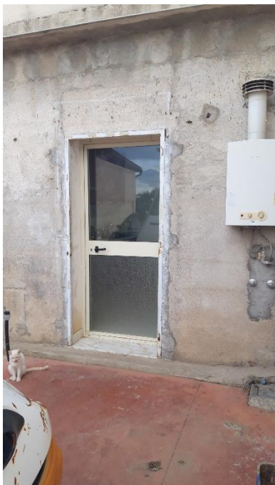
Ingresso Lato Nord – Cucina 1
