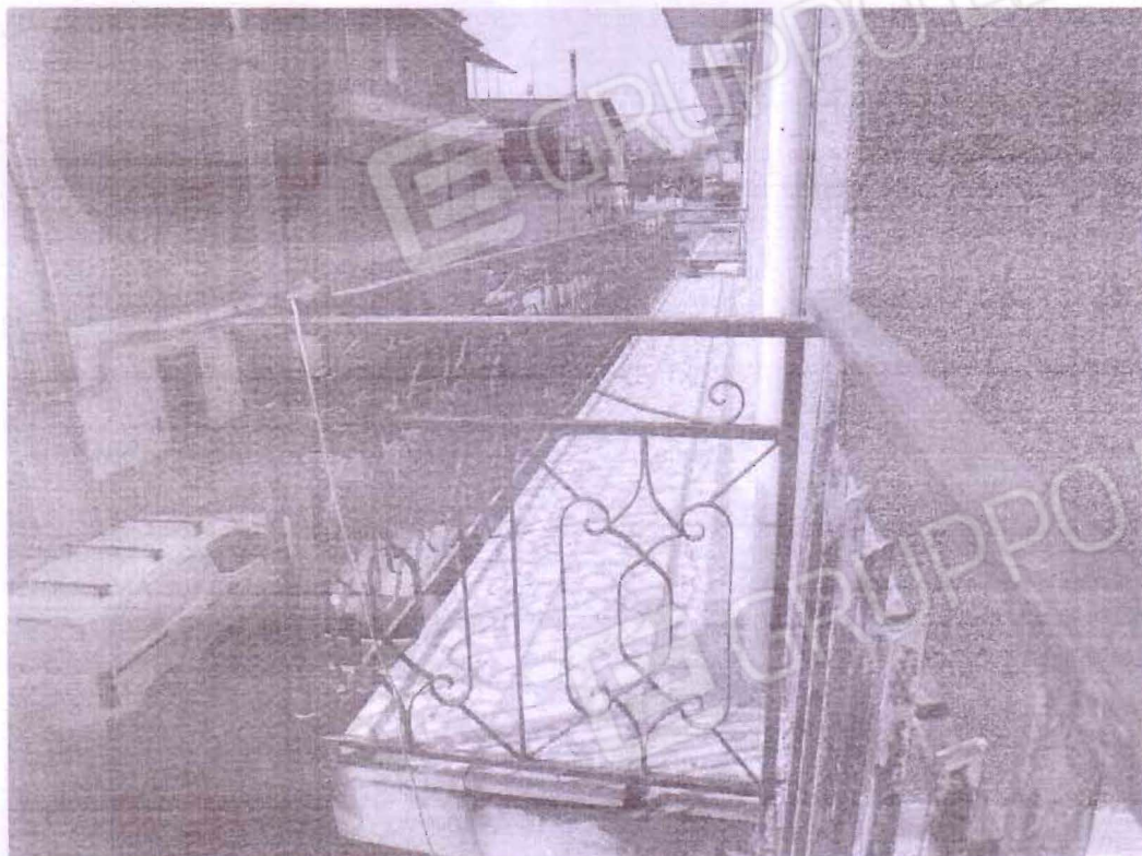
Foto 23. Vista del balcone su Via della Pietà
