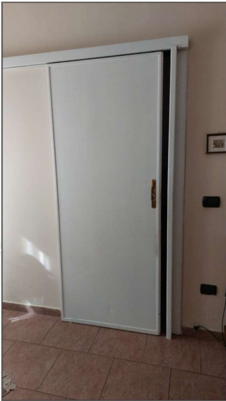
Ingresso all'immobile P.T.
