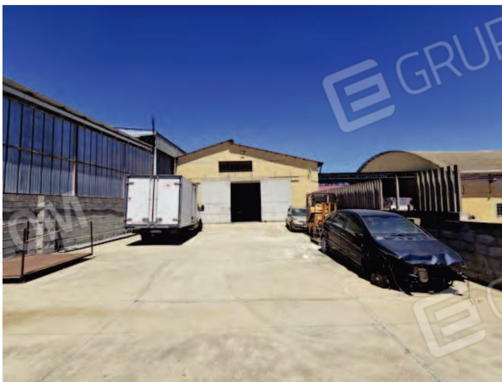
Fotografia E.2 - Prospetto
