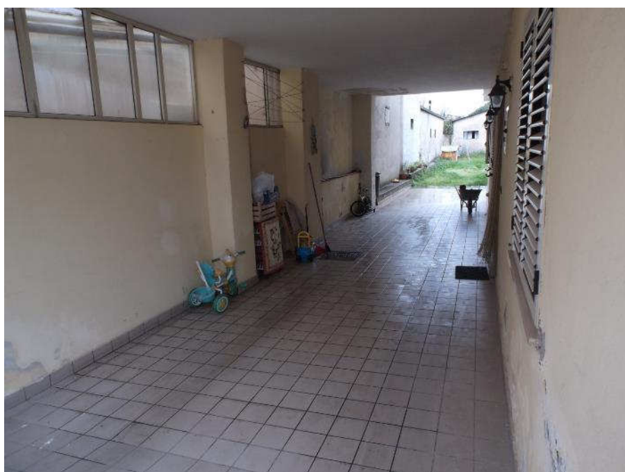
Foto n° 120 - Prospetto sud e porticato
