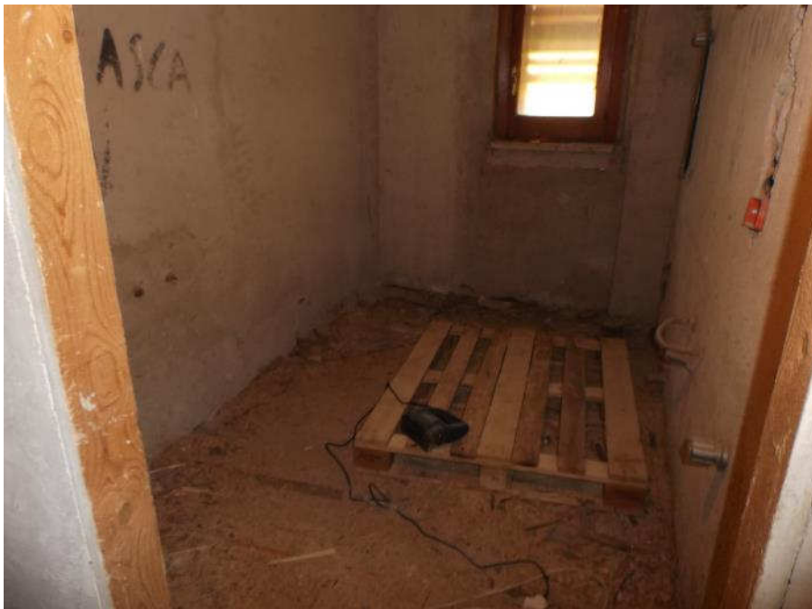
Foto n°89 - Piano terra rialzato - Bagno n° 2
