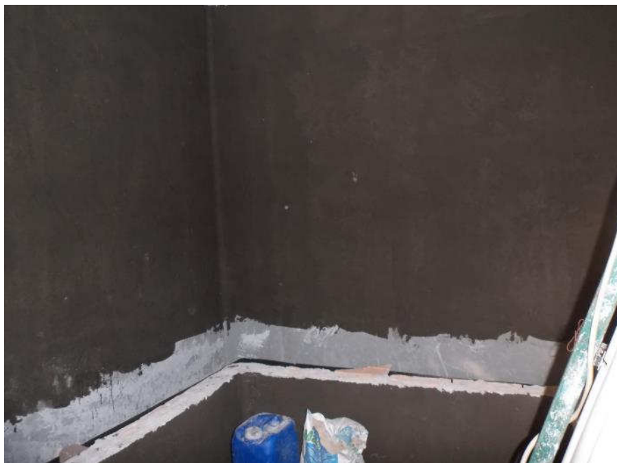
Foto n° 60 - Piano terra - Bagno turco
