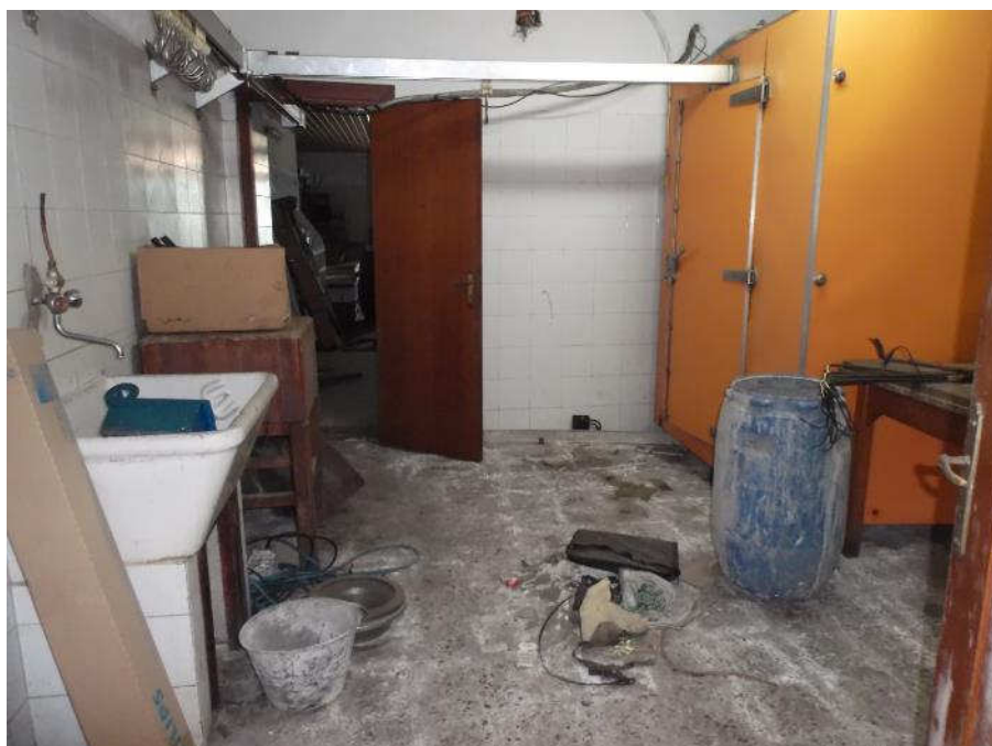
Foto n°100 - Piano terra - Vano n° 3
