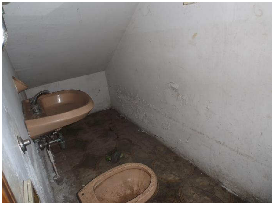
Foto n° 101- Piano terra – Bagno sotto scala
