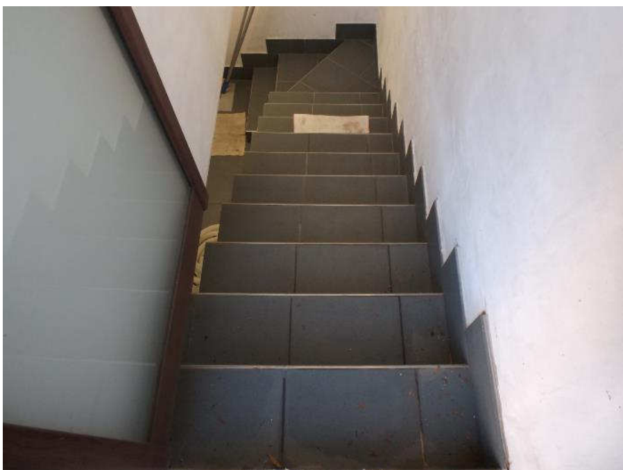
Foto n° 64 - Scala di collegamento piano interrato-piano terra
