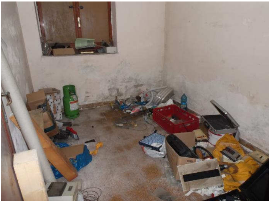
Foto n° 97 - Piano terra - Vano n° 1
