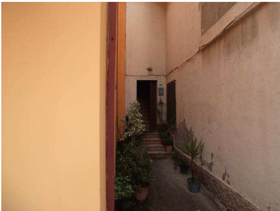
Foto n° 103 - Particolare accesso al piano primo
