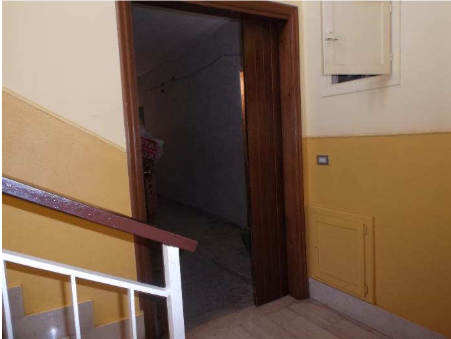
Foto n° 81- Piano terra rialzato – Ingresso appartamento pignorato
