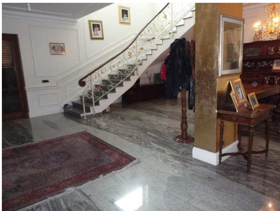
Foto n° 12- Piano terra – Scala di accesso al piano primo (Sub 6)
