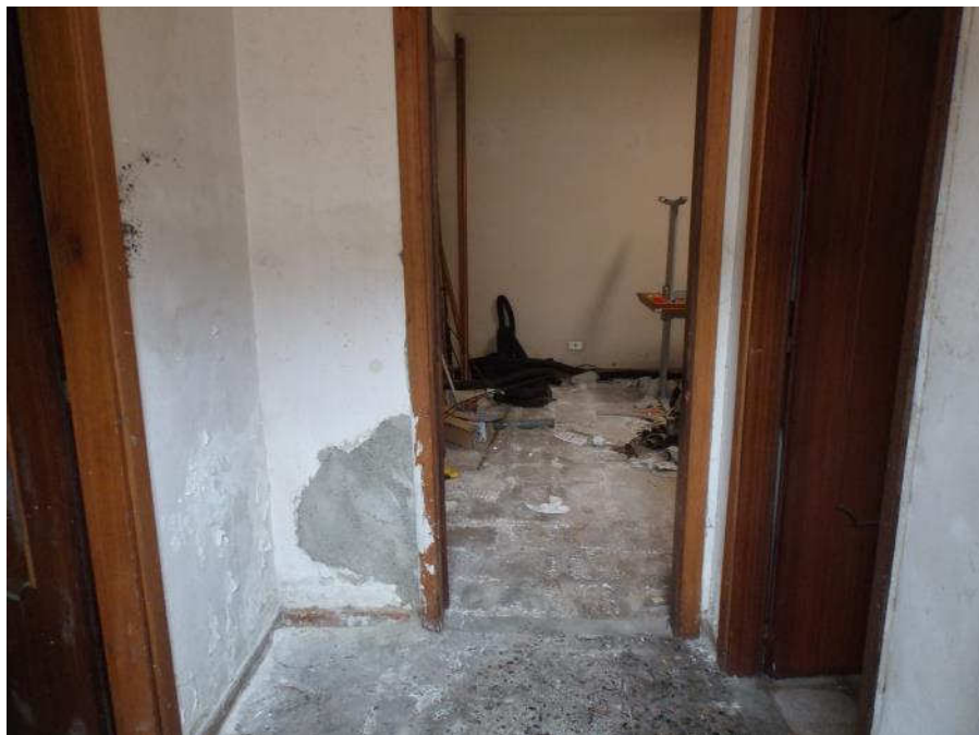
Foto n° 95- Piano terra - Disimpegno
