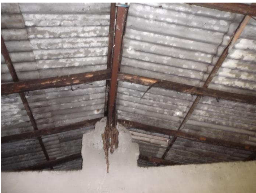
Foto n° 150- Particolare copertura realizzata con pannelli in eternit
