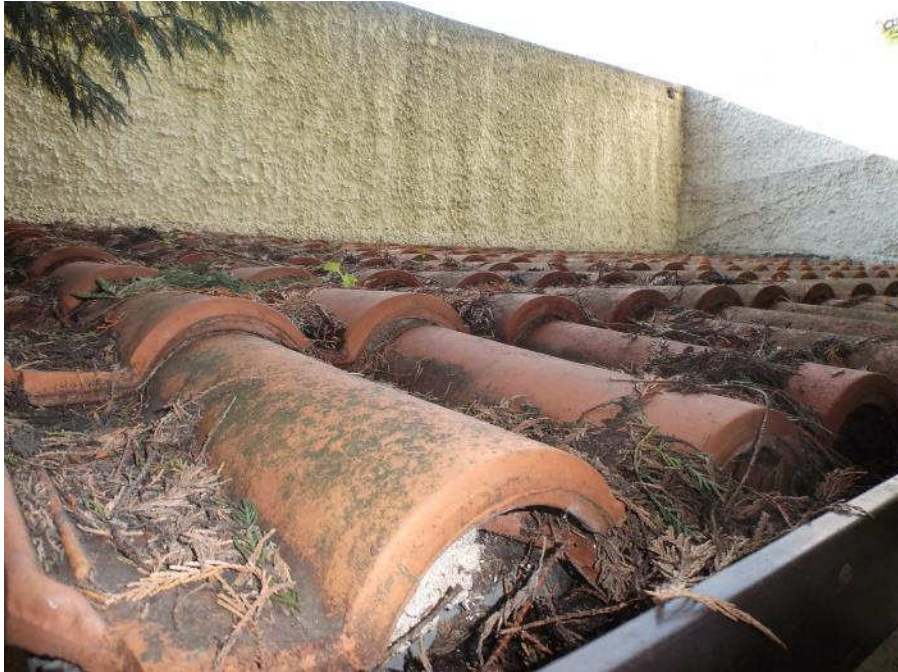
Foto n° 77 - Cabina elettrica - Copertura
