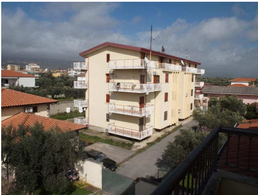
Foto n° 79- Prospetto sud fabbricato ospitante il sub 3
