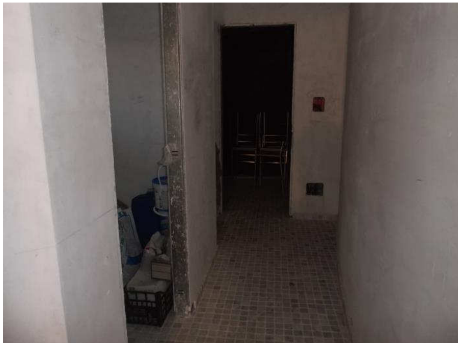
Foto n°61 - Piano terra - Corridoio
