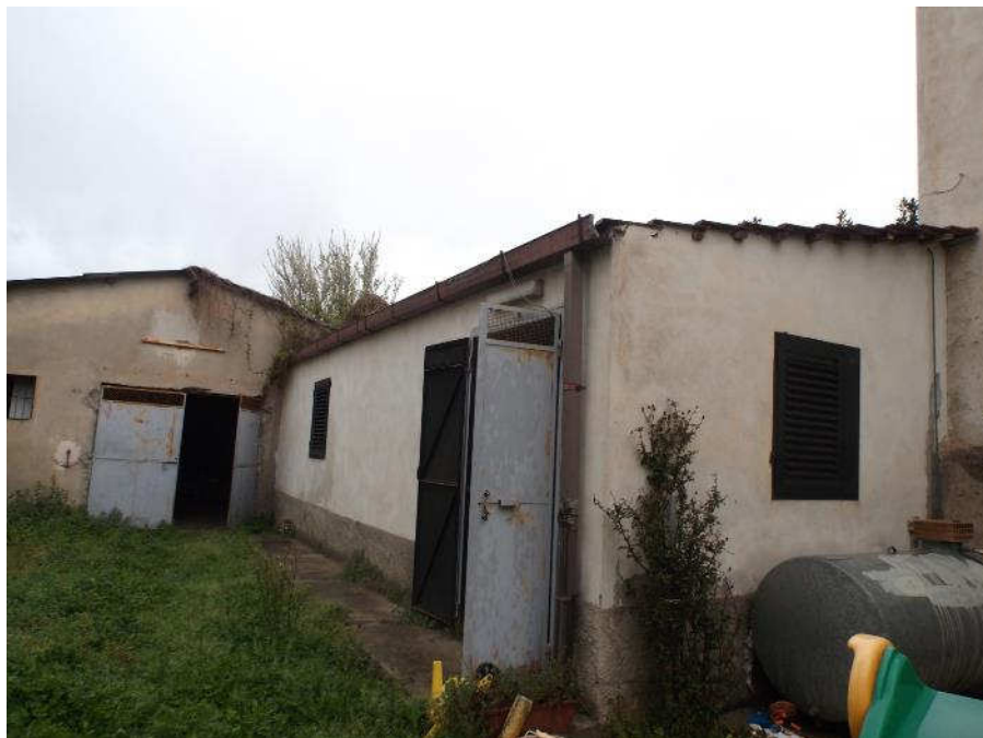
Foto n° 145 - Particolare ingresso deposito n° 1
