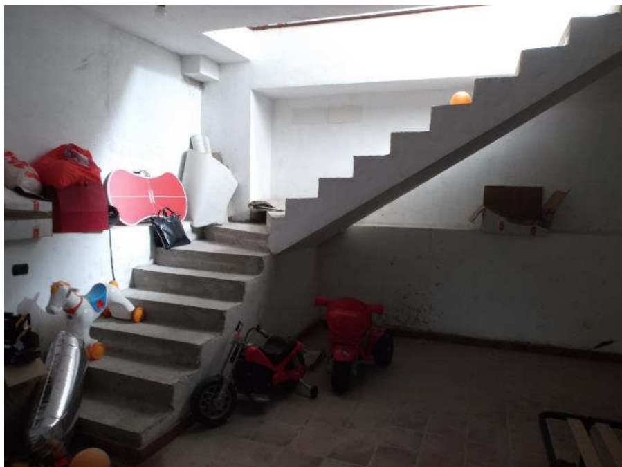
Foto n° 39- Piano interrato - Scala di collegamento piano interrato-piano terra lato ovest (sub 8)
