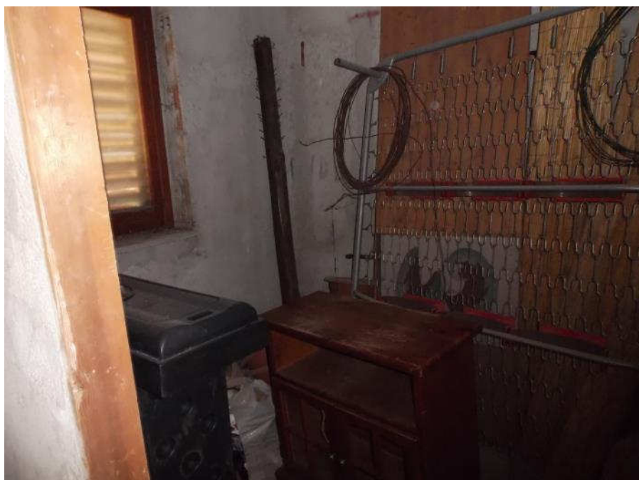
Foto n° 84- Piano terra rialzato - Bagno n° 1
