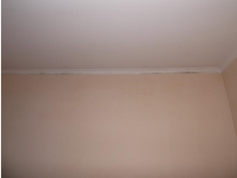
Foto n° 23- Piano primo - Particolare presenza macchie di umidità nella camera da letto n° 3 (Sub 8)
