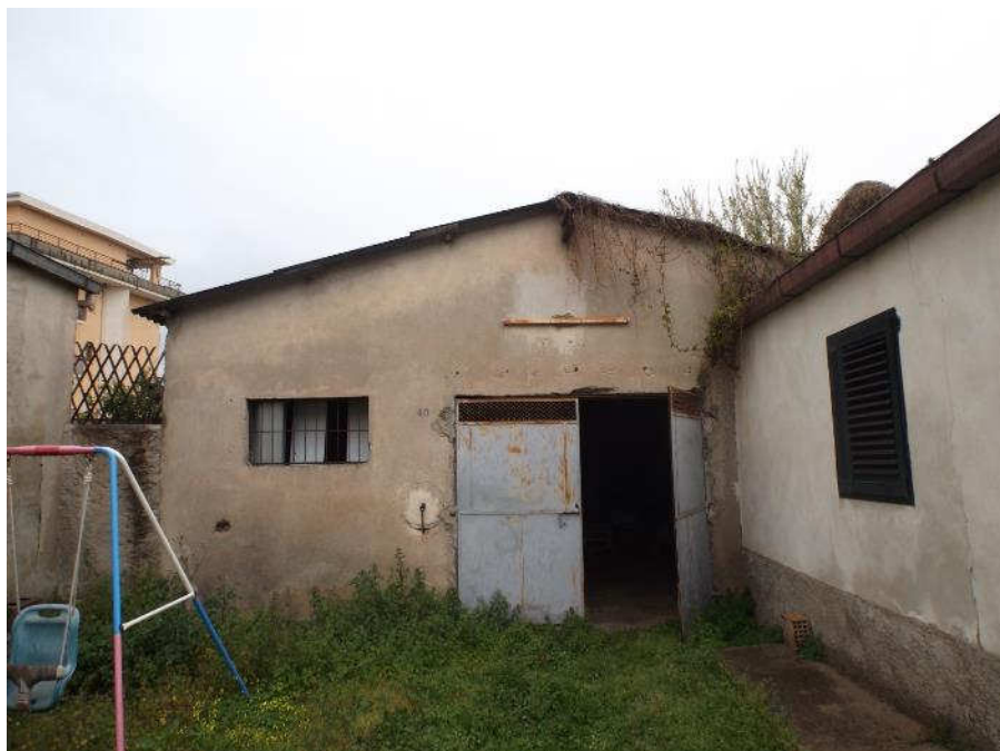
Foto n°147 - Ingresso deposito n° 2
