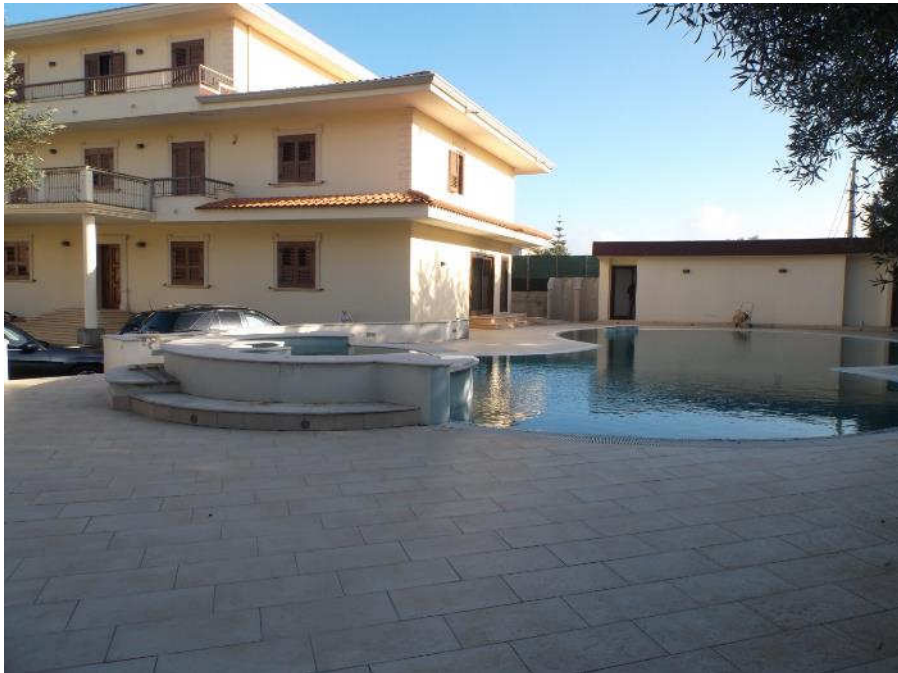
Foto n°51 - Corte esterna (sub 5)
