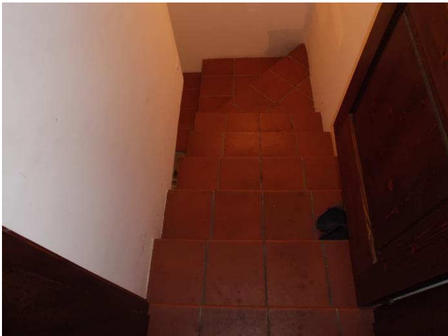
Foto n° 75 - Scala di collegamento piano interrato-piano terra
