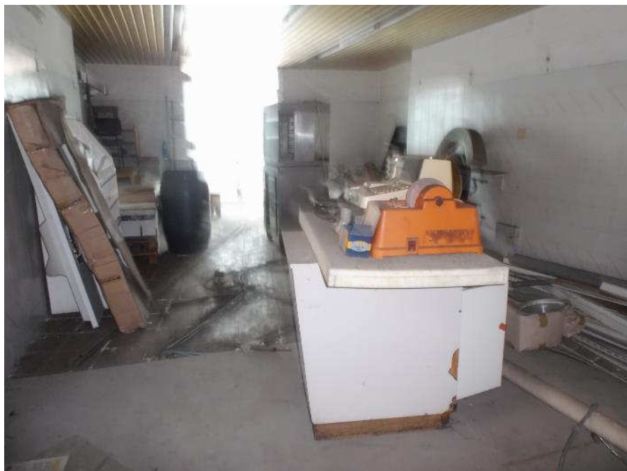
Foto n° 102- Piano terra - Vano n° 4
