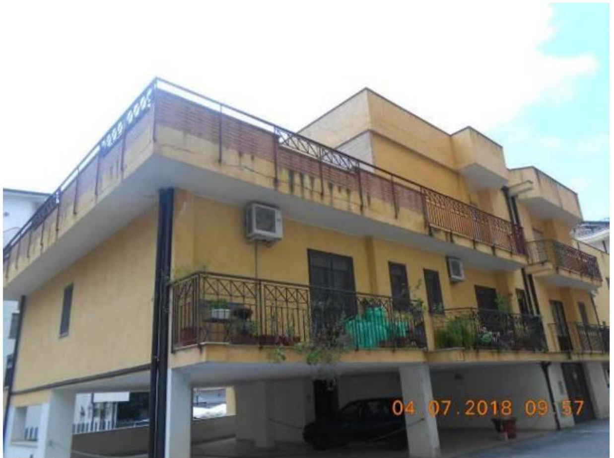
Foto prospetto Fabbricato.
