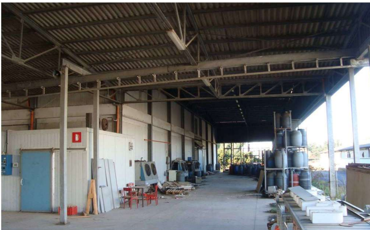
■ Figura 23 vista interna della tettoia del fabbricato opificio della particella 52 foglio 32 comune di Lamezia Terme
