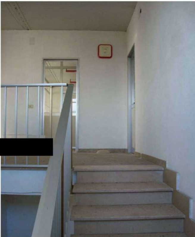
■ Figura 31 vista interna del fabbricato officio della particella 52 foglio 32 comune di Lamezia Terme
