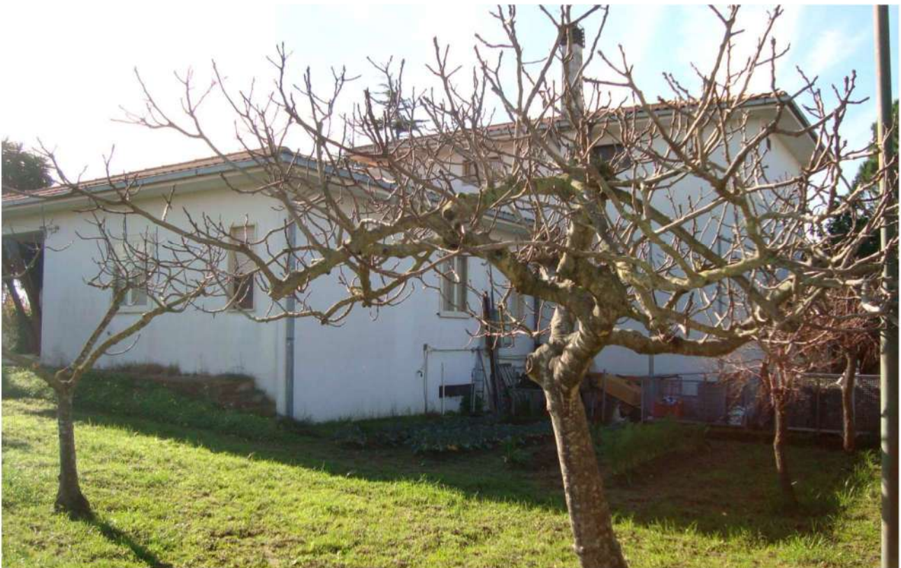
■ Figura 37 vista esterna del fabbricato della particella 116 foglio 32 comune di Lamezia Terme
