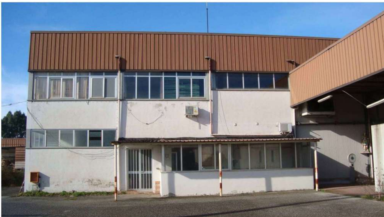
■ Figura 22 vista del fabbricato opificio della particella 52 foglio 32 comune di Lamezia Terme
