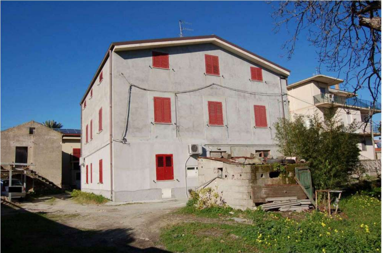
■ Figura 9 vista del fabbricato del comune di davoli, relativamente alle particelle 131 sub 2 e 3 foglio 5
