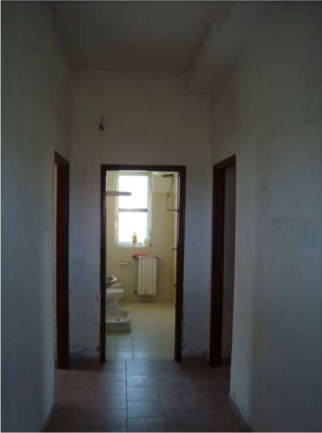
■ Figura 50 vista interna del fabbricato della particella 117 foglio 32 comune di Lamezia Terme
