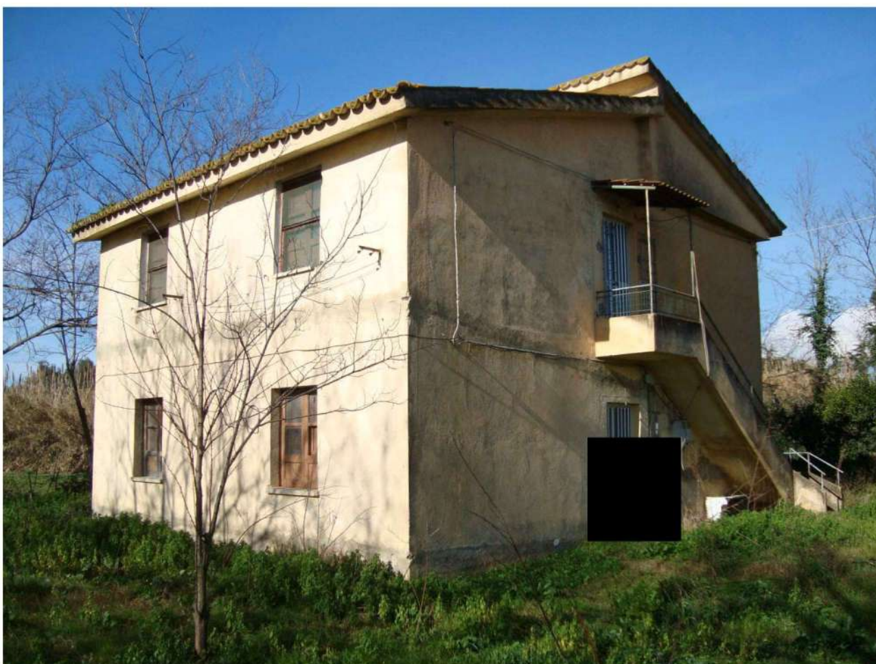
■ Figura 47 vista esterna del fabbricato della particella 117 foglio 32 comune di Lamezia Terme
