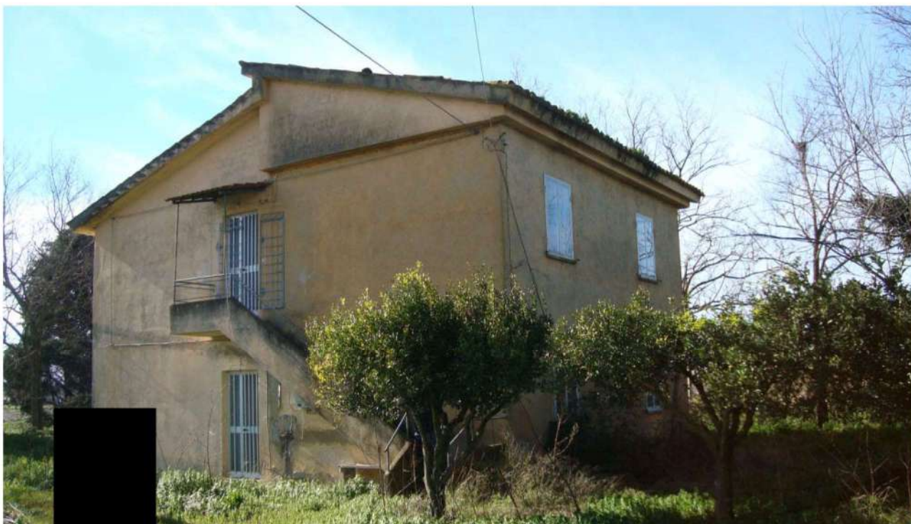
■ Figura 46 vista esterna del fabbricato della particella 117 foglio 32 comune di Lamezia Terme
