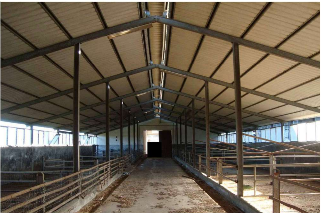
■ Figura 19 vista interna del fabbricato stalla della particella 167 foglio 32 comune di Lamezia Terme
