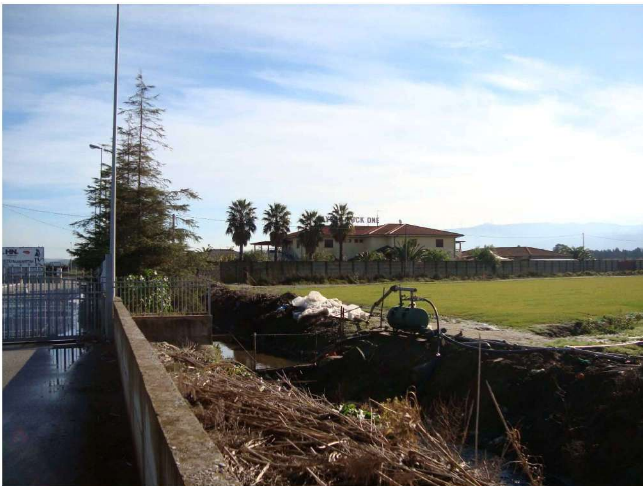
■ Figura 3 vista dell'accesso alla particella 26 foglio 32, impedito dal cancello del parcheggio della discoteca
