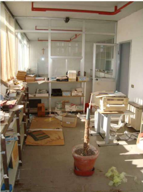
■ Figura 33 vista interna degli uffici al piano primo del fabbricato opificio della particella 52 foglio 32 comune di Lamezia Terme
