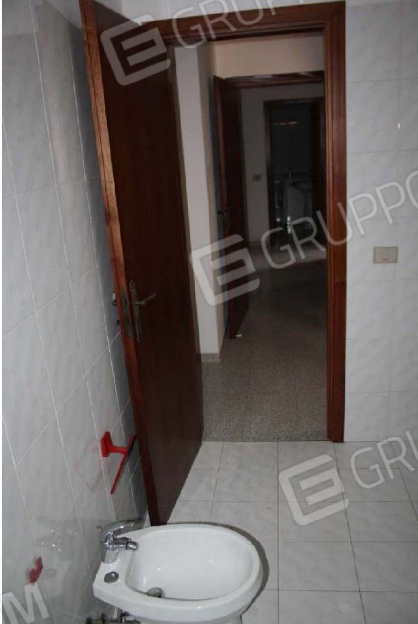
Foto n°22 – Altra vista del bagno principale
