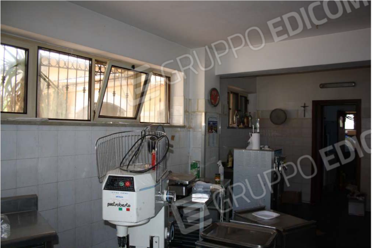
Foto n°8 – Altra vista interna del locale lato Est - Fg. 23 P.Ila 1130 sub 2
