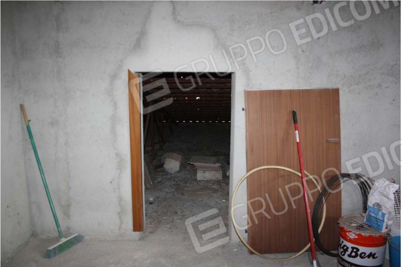
Foto n°6 – Apertura sul sottotetto.
