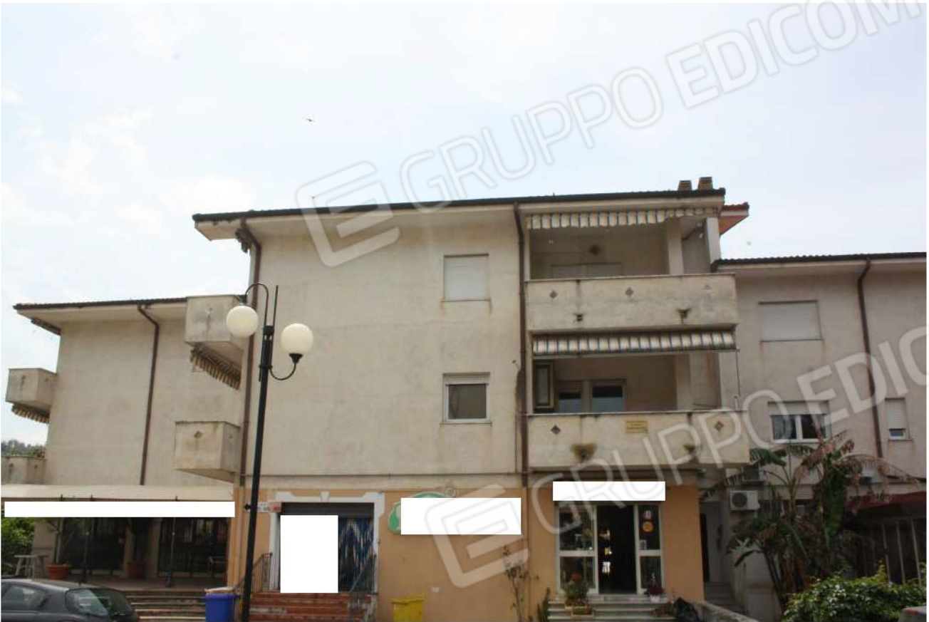
Foto n°1 – Vista esterna dell'immobile, sono in particolare visibili le due entrate principali, che identificano due locali distinti e separati, del bene identificato come Fg. 23 P.Ila 1130 sub 2.
