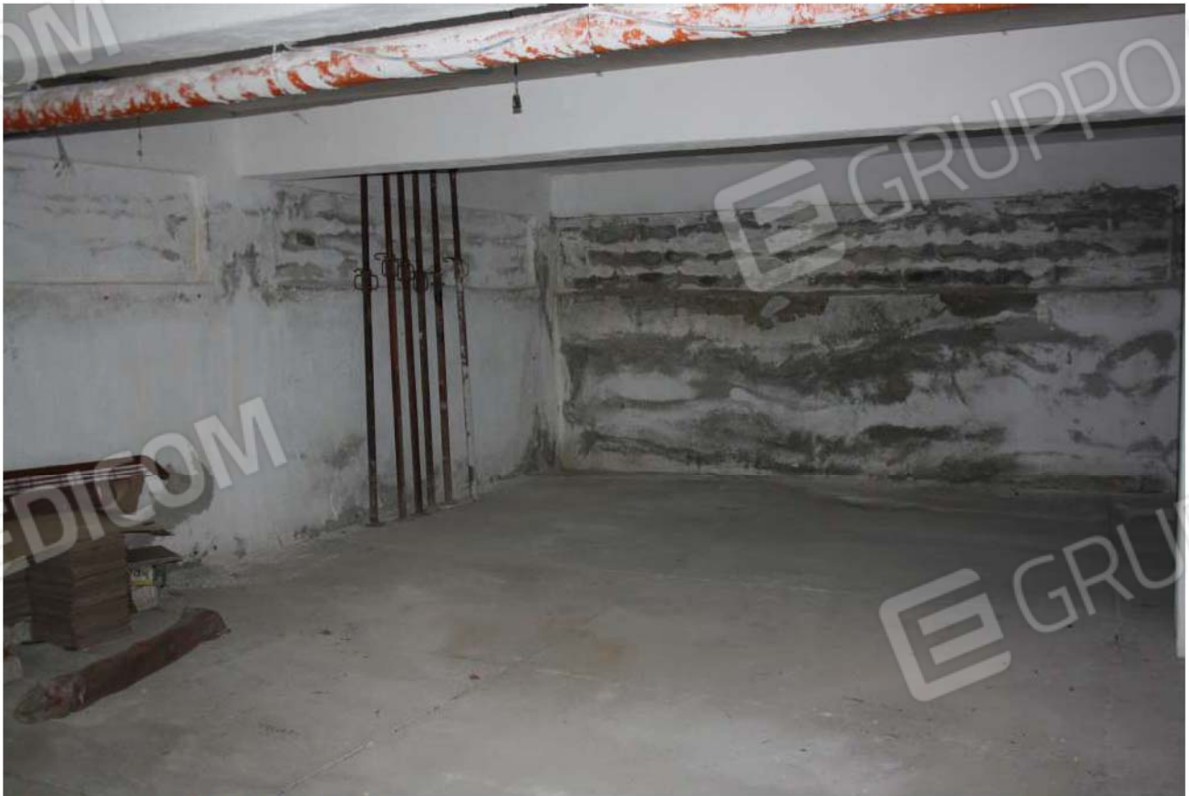
Foto n°6 – Locali garage, altra vista
