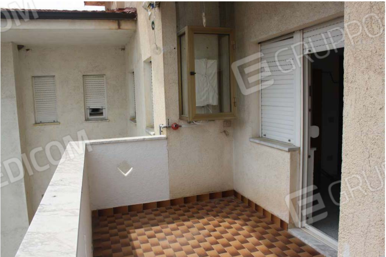
Foto n°20 – Balcone della seconda camera da letto piccola
