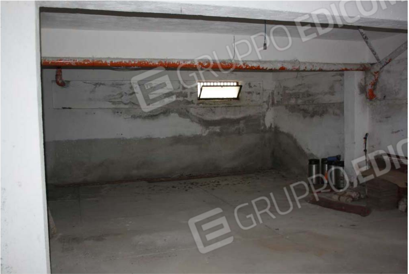
Foto n°5 – Locali garage, altra vista
