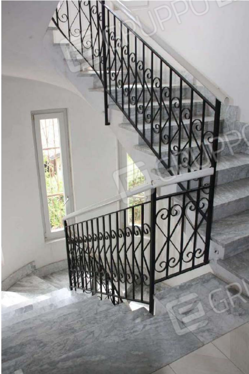
Foto n°10 – Ingresso vano scala
