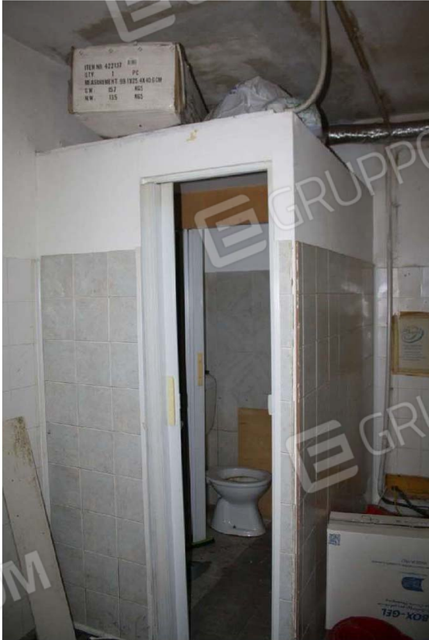
Foto n°10 – Altra vista interna del bagnetto di servizio del locale lato Est - Fg. 23 P.Ila 1130 sub 2
