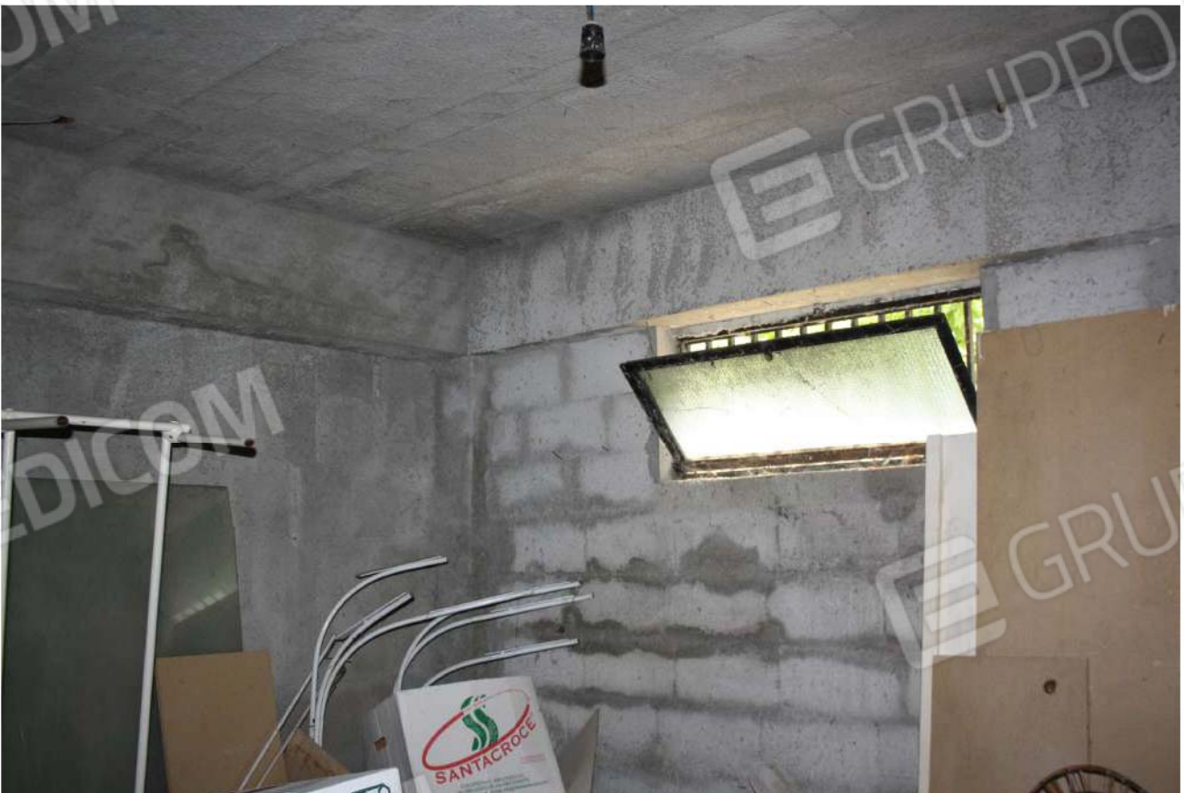
Foto n°8 – Locali garage, vista dell'interno della porzione distaccata
