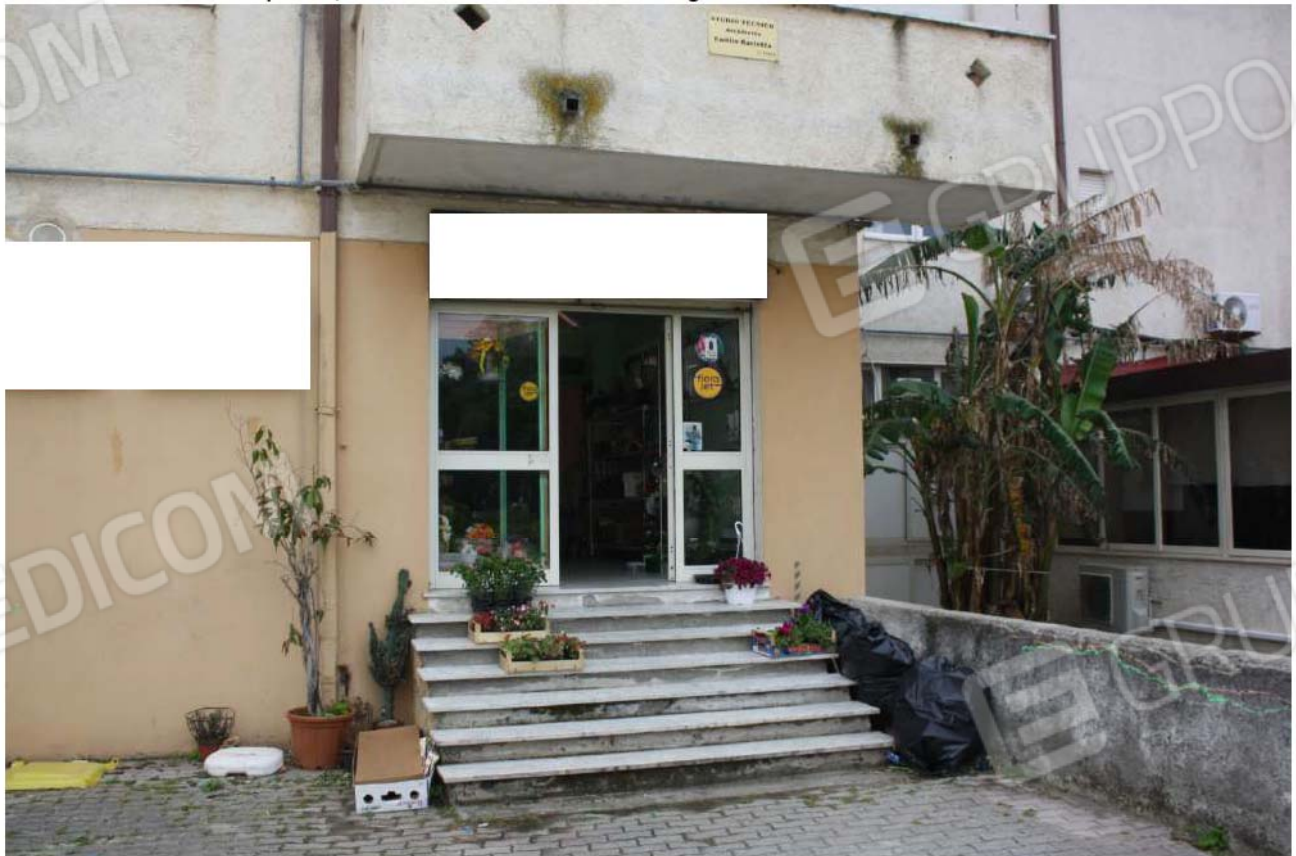
Foto n°2 – Vista esterna particolareggiata dell'ingresso lato Ovest - Fg. 23 P.Ila 1130 sub 2
