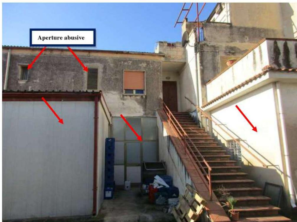
Foto 60: Prospetto Est del fabbricato a tre piani f.t. (part. 655): le frecce indicano le opere abusive
