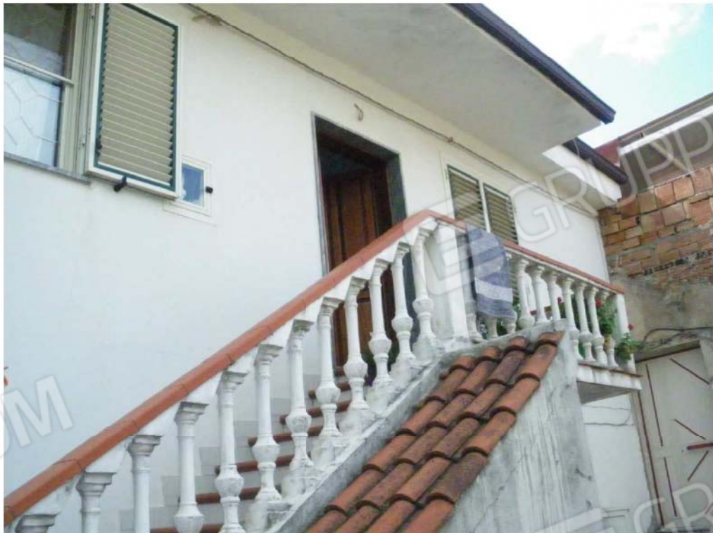
FOTO N° 10 – SCALA D'ACCESSO AL PRIMO PIANO
