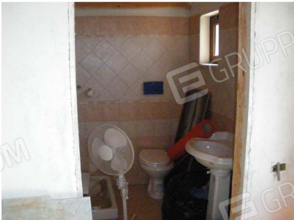
Foto N° 22 – BAGNO IN CORSO DI COSTRUZIONE
