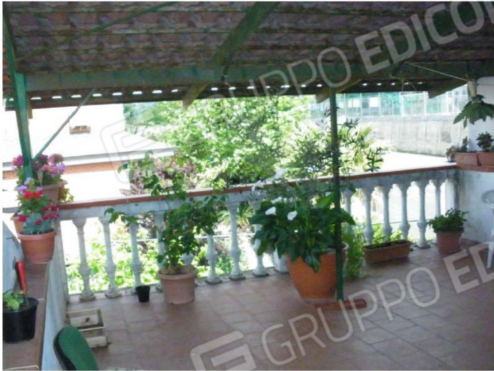
Foto N° 21 – ALTRA VISTA DELLA TERRAZZA
