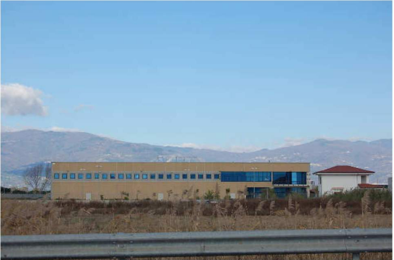
■ Figura 23 lotto 3 vista esterna dalla strada statale n.18.
