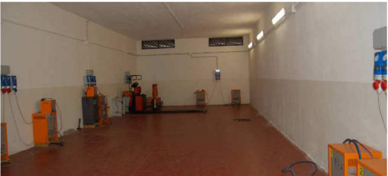
■ Figura 39 lotto 3 vista interna compendio immobiliare – deposito piano terreno-locale carica batterie.
