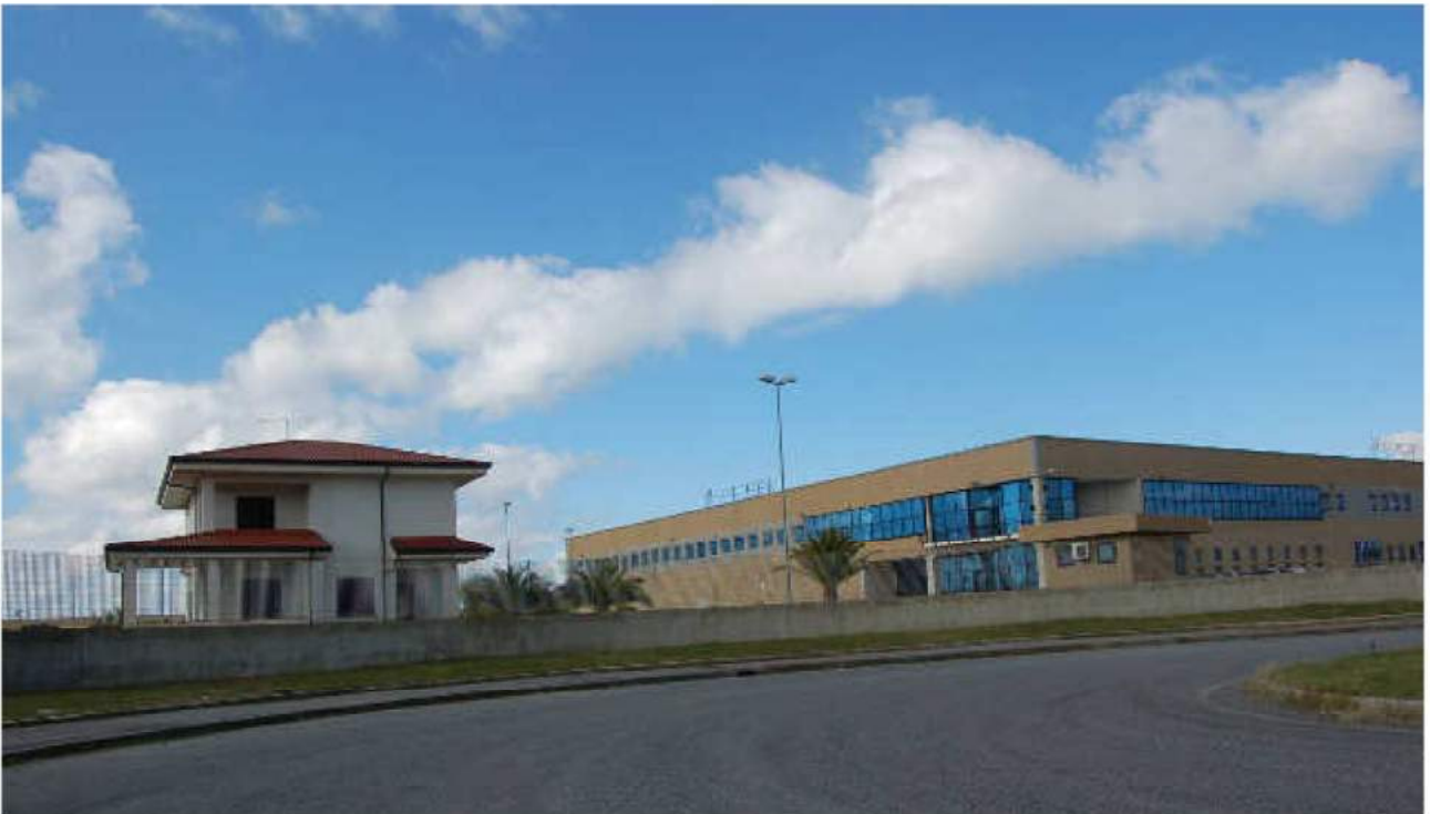
■ Figura 24 lotto 3 vista esterna dalla strada statale n.18.
