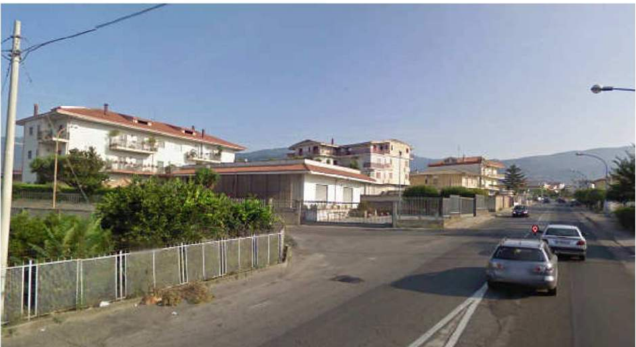
■ Figura 2 lotto 1 e 2 vista accesso alla particella 1109 foglio 31 dalla strada 108
