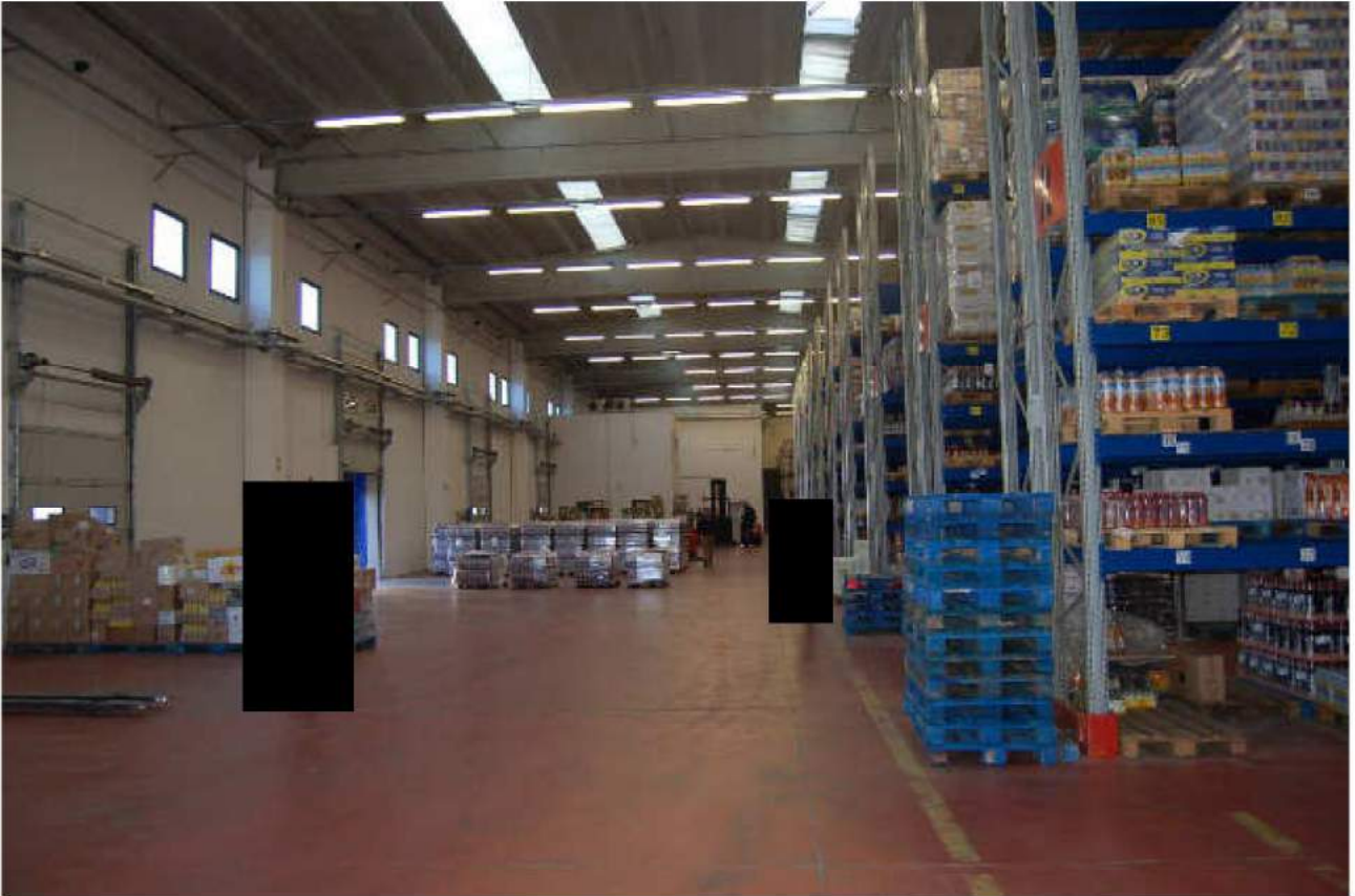
■ Figura 35 lotto 3 vista interna compendio immobiliare – deposito piano terreno.
