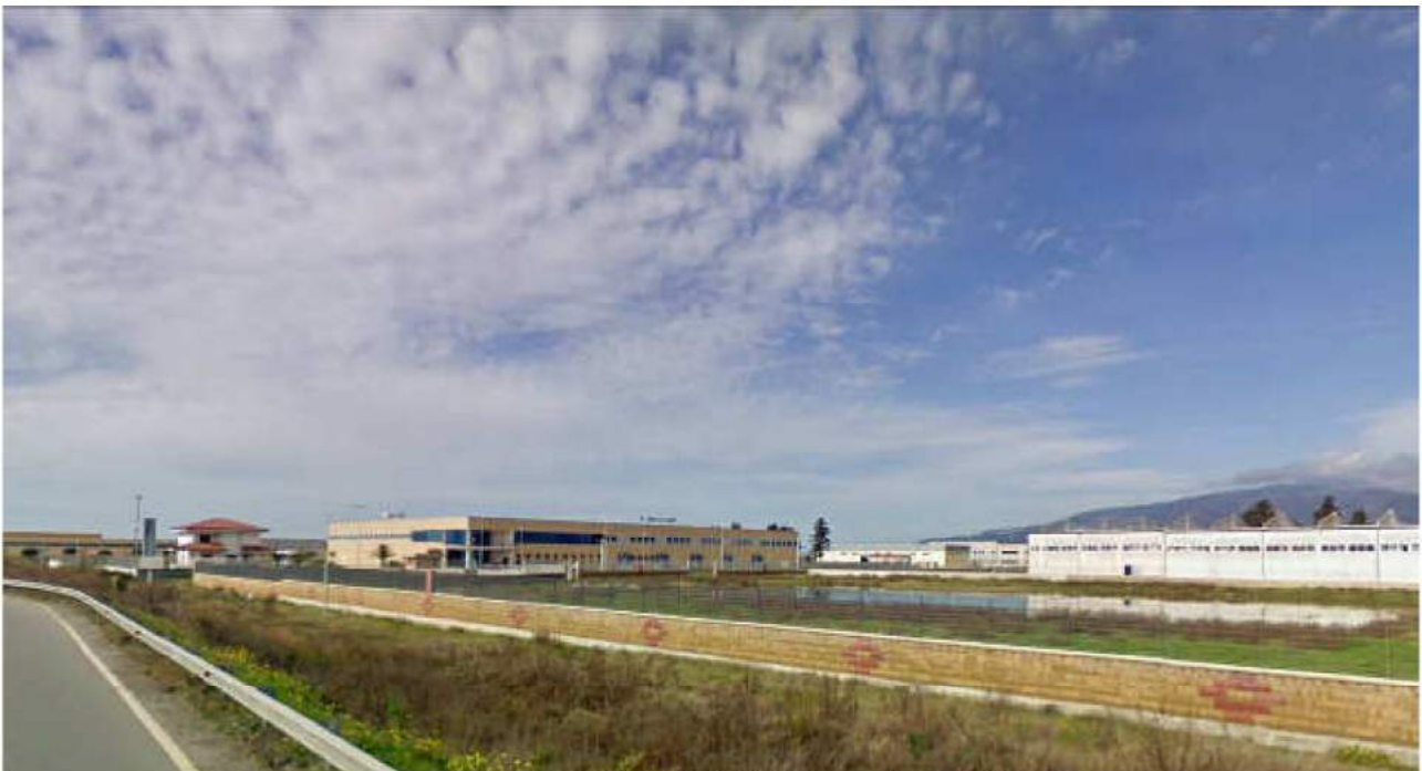
■ Figura 22 lotto 3 vista esterna dalla strada statale n.18.
