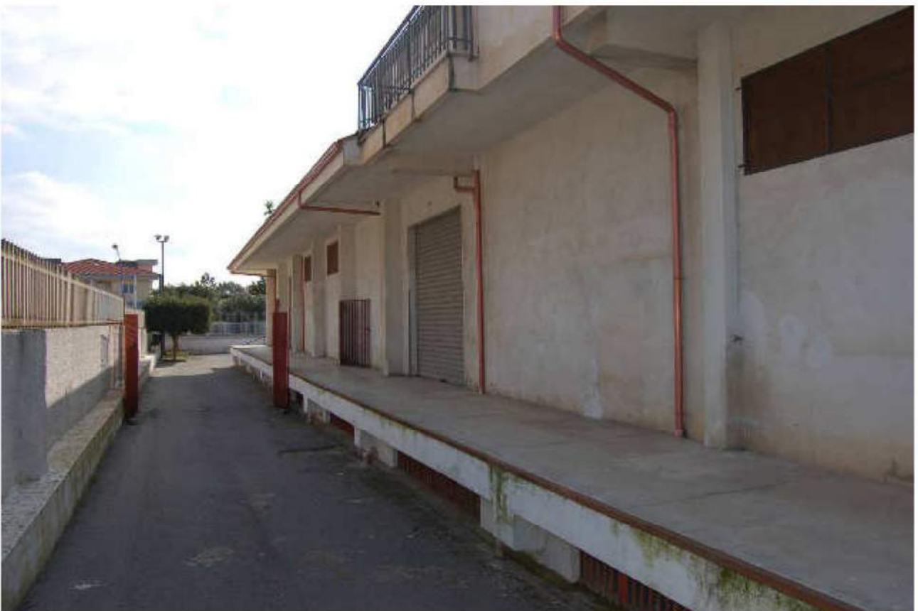
■ Figura 8 lotto 1 e 2 vista degli esterni.
