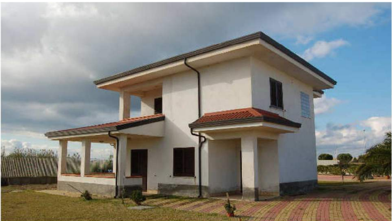
■ Figura 32 lotto 3 vista esterna compendio immobiliare- alloggio del custode ed uffici.
