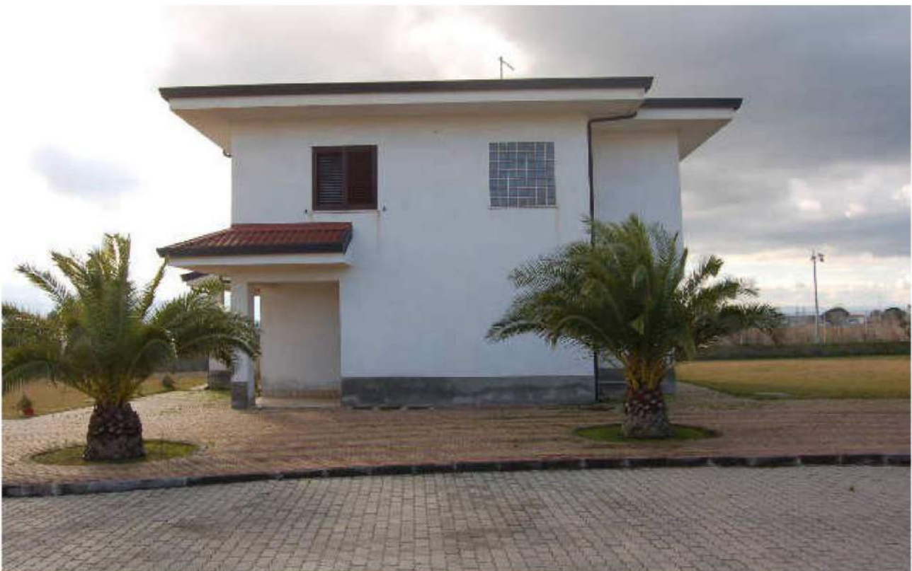
■ Figura 34 lotto 3 vista esterna compendio immobiliare- alloggio del custode.
