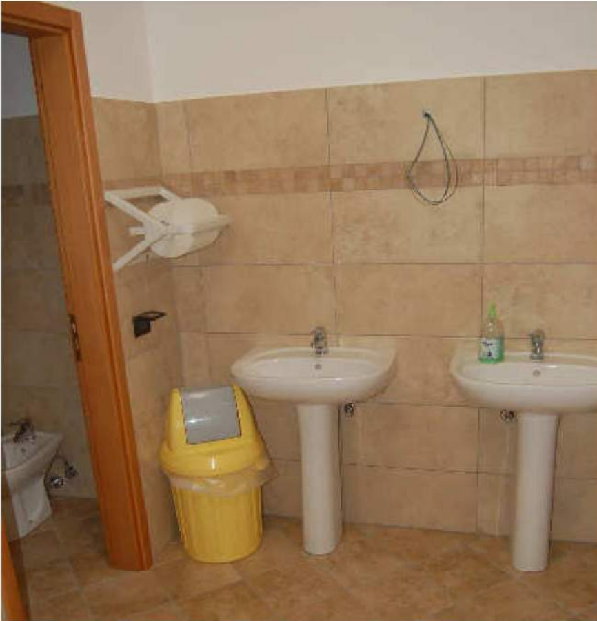
■ Figura 48 lotto 3 vista interna compendio immobiliare – uffici piano primo- wc.
