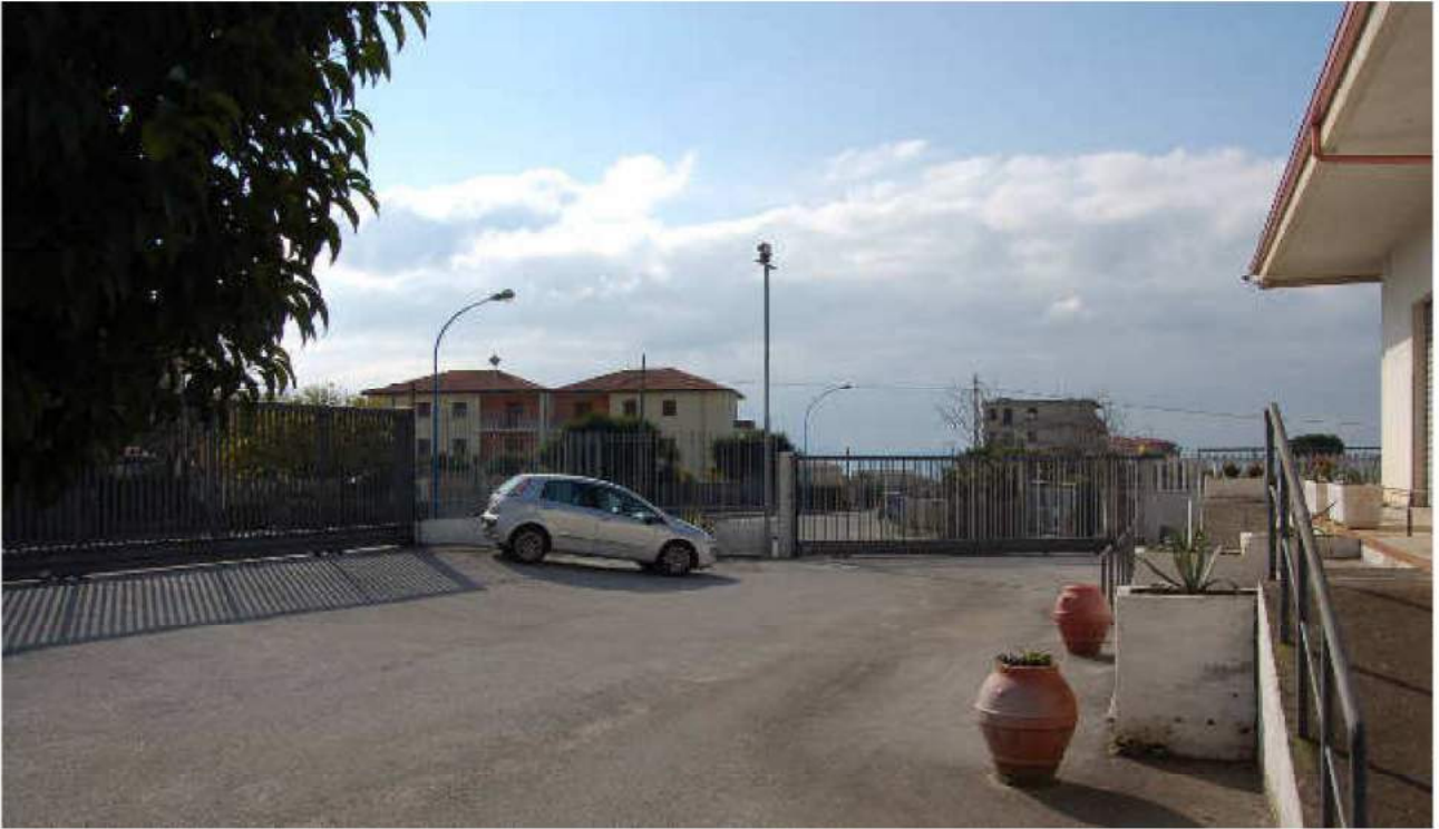
■ Figura 7 lotto 1 e 2 vista degli esterni.
