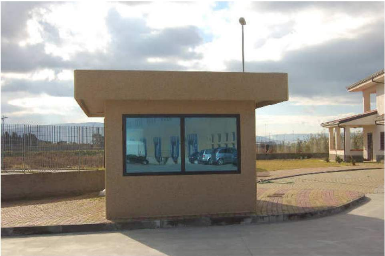
■ Figura 31 lotto 3 vista esterna compendio immobiliare – locale guardiola.
