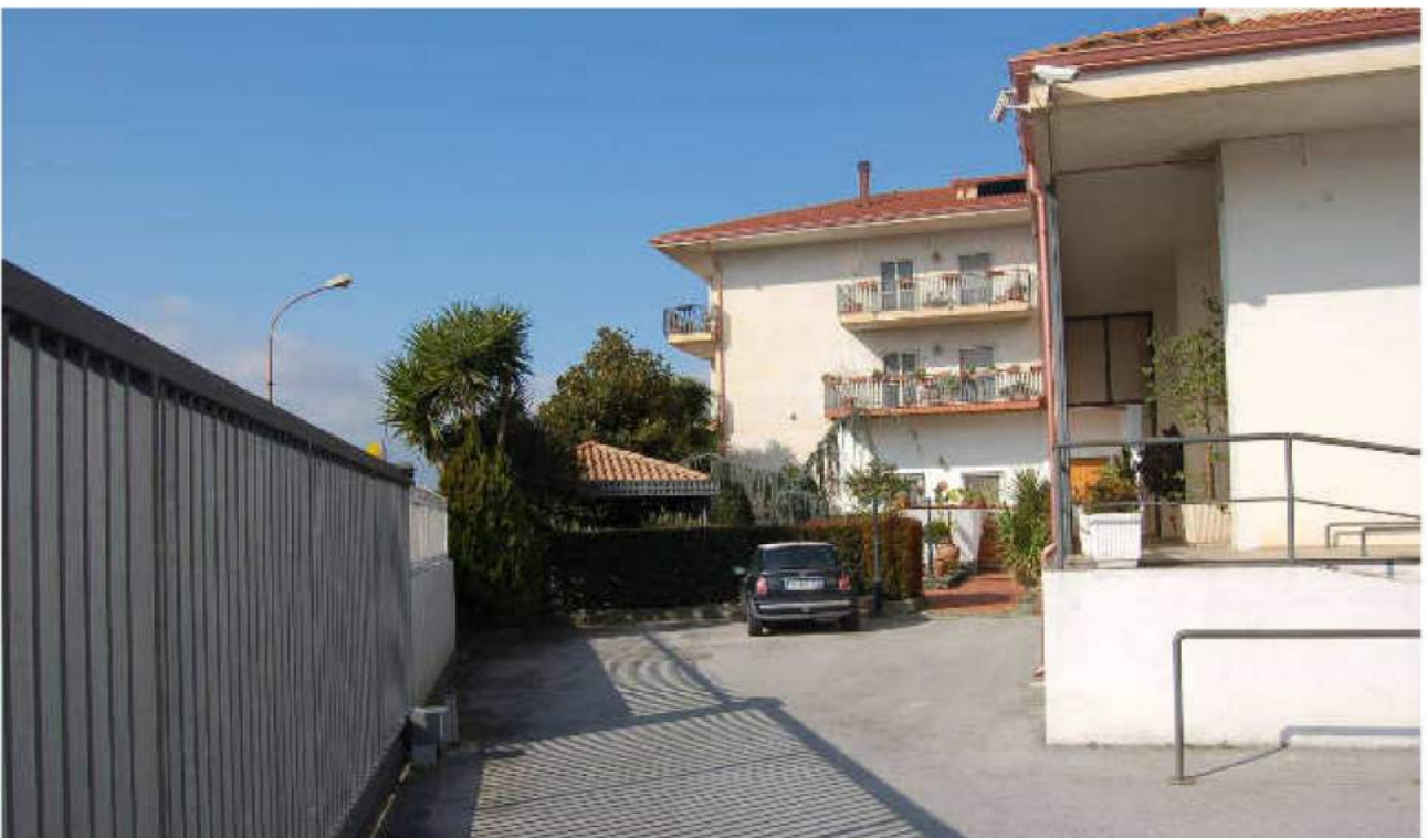
■ Figura 6 lotto 1 e 2 vista degli esterni.
