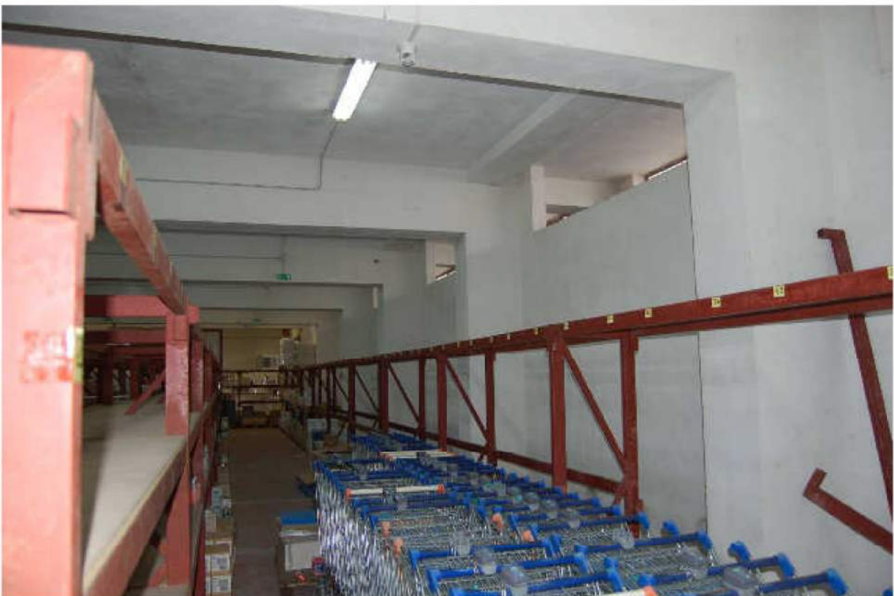
■ Figura 16 lotto 1 e 2 vista degli interni particella 1109 sub 2 foglio 31.
