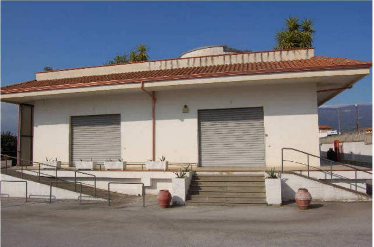
■ Figura 5 lotto 1 e 2 vista degli esterni.
