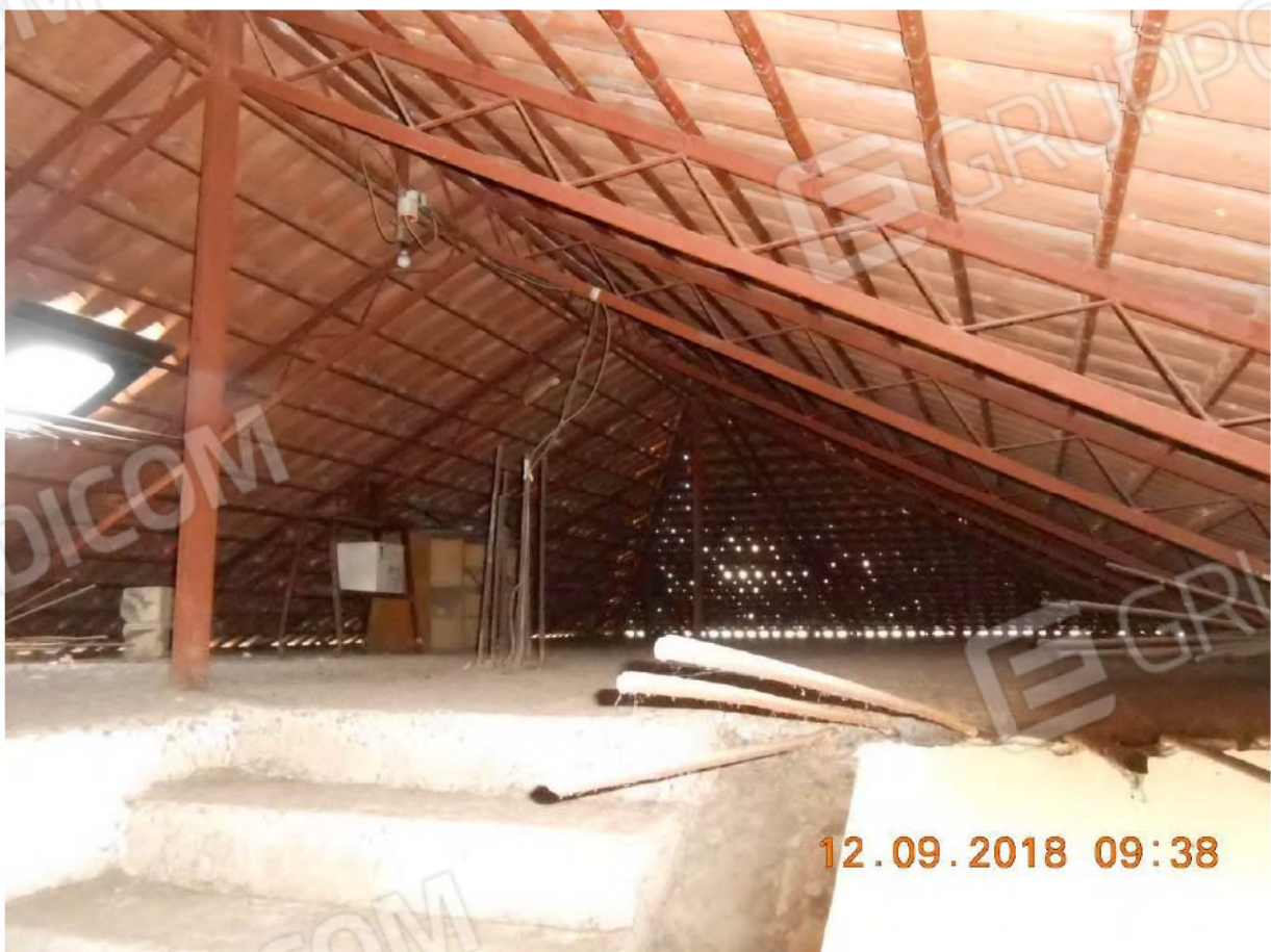
Foto 22. Sottotetto – piano secondo
