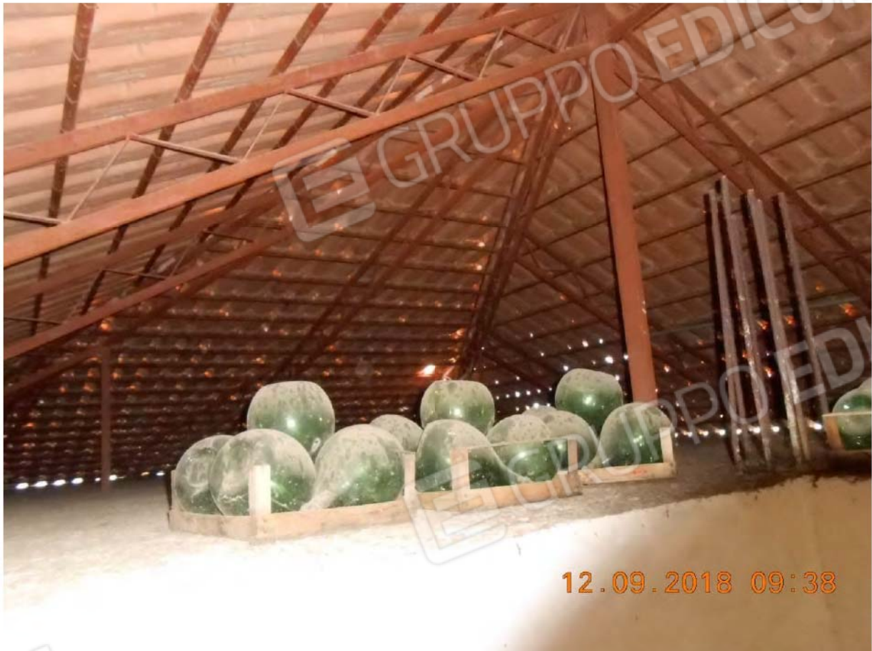
Foto 21. Sottotetto – piano secondo
