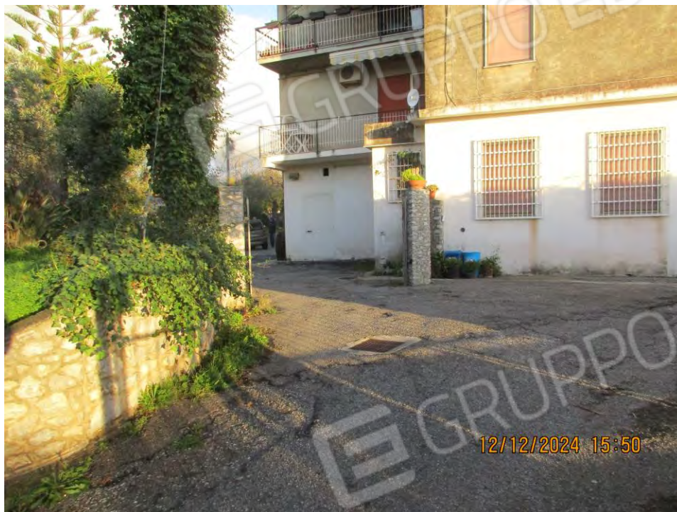
Foto n. 5 – Ingresso comune ai beni descritti nei lotti nn. 1, 2 e 3
