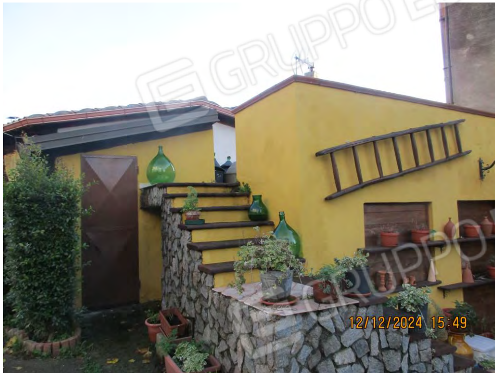
Foto n. 43 – Scala di accesso al Terrazzo di copertura
