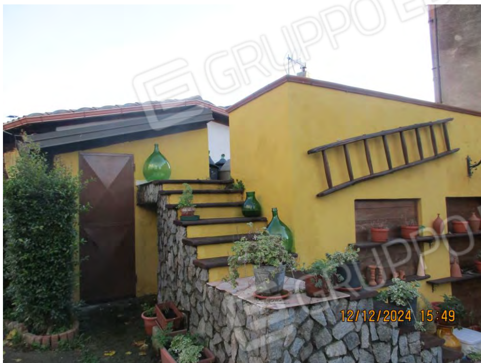
Foto n. 35 – Particolare scala di accesso al terrazzo di copertura del fabbricato identificato con la particella 269
