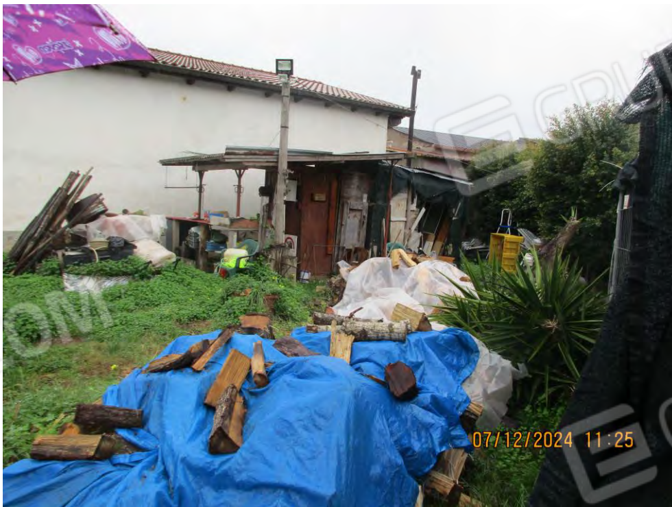
Foto n. 32 – Strutture precarie in ferro e legno
