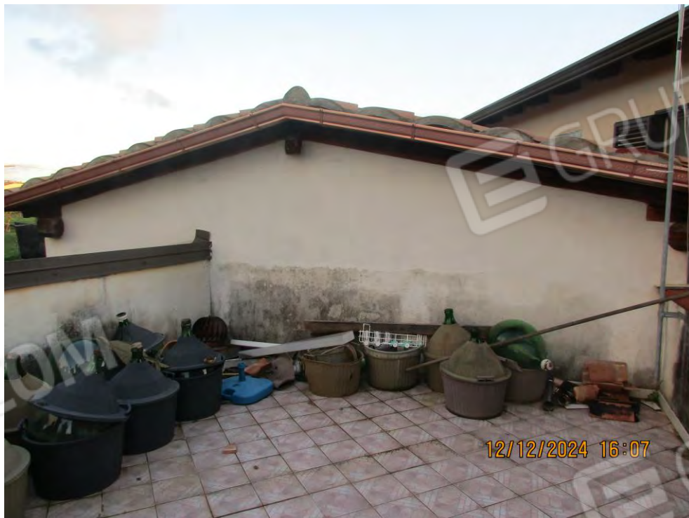
Foto n. 44 – Terrazzo di copertura
