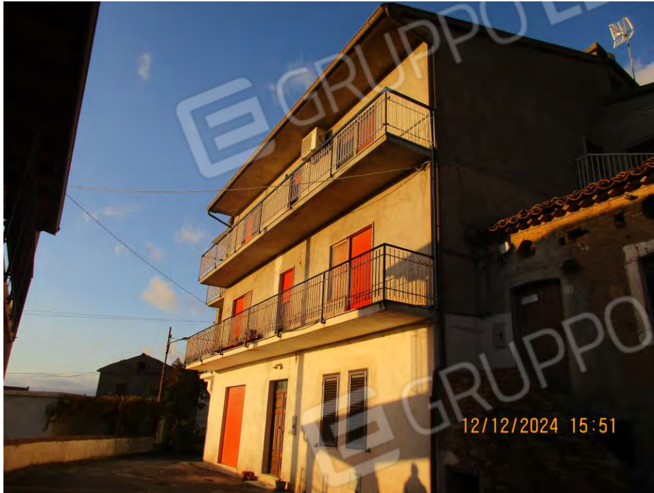
Foto n. 3 – Prospetto Sud fabbricato ospitante i beni descritti nei lotti nn. 1 e 2
