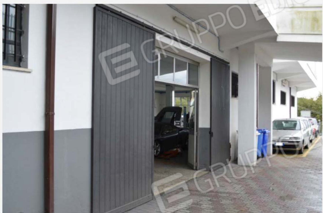
3 - Particolare del lato ovest, piano terra
