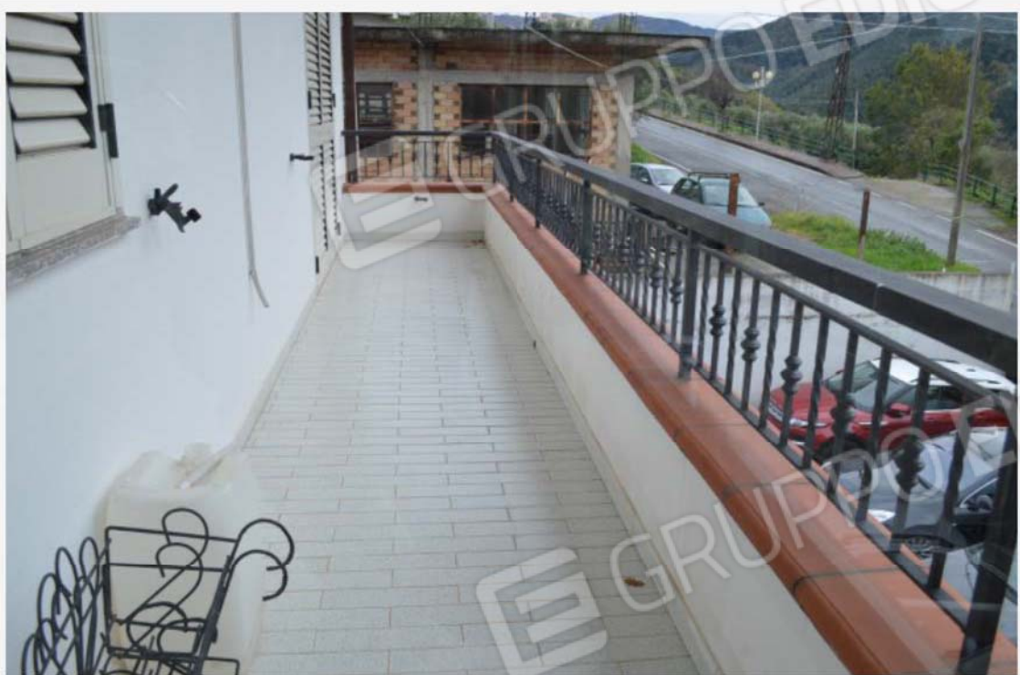
19 - Vista del balcone sul lato sud dell'edificio
