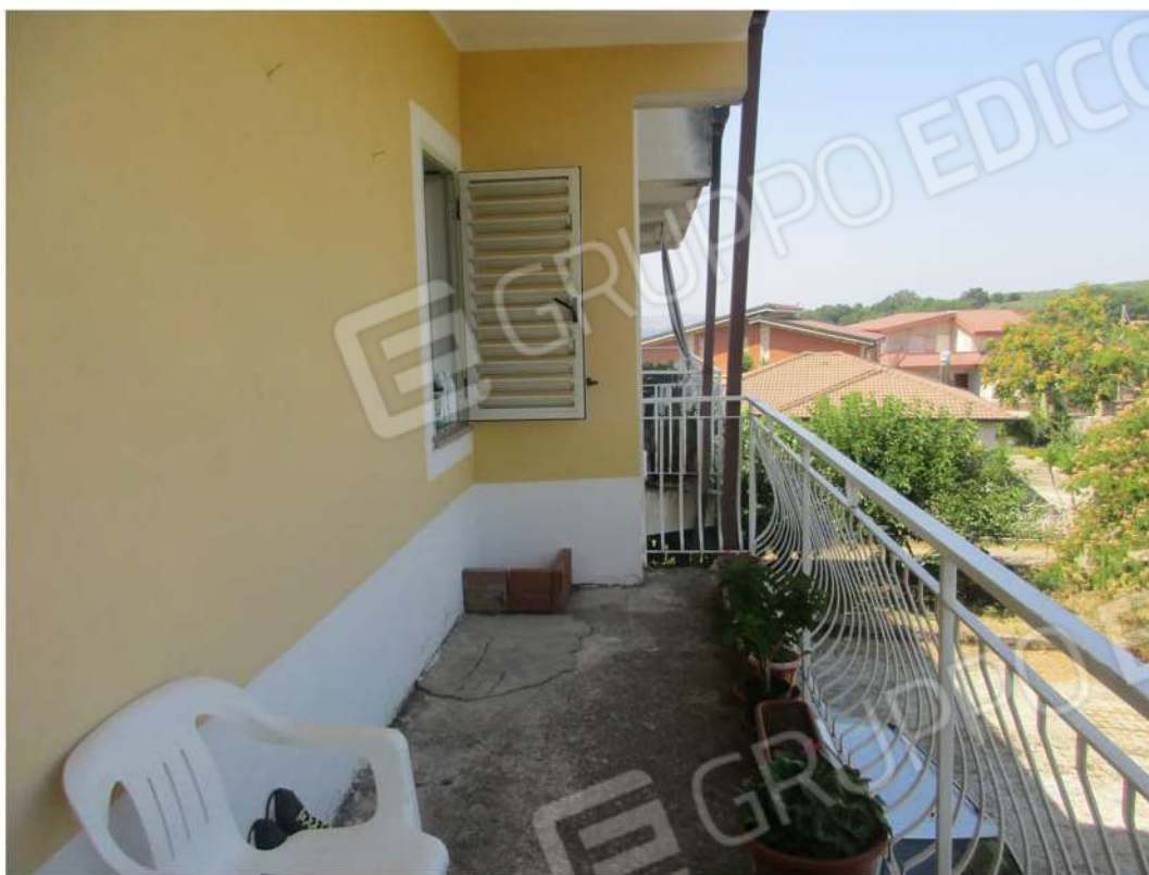
Foto 53: Il balcone sul prospetto ovest: in evidenza l'assenza della pavimentazione
