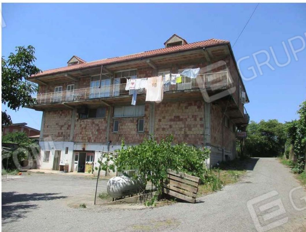
Foto 4: Prospetto est del fabbricato
