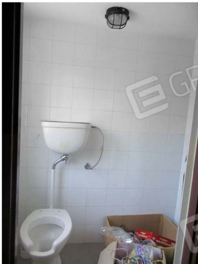
Foto 37: Vista del servizio igienico
