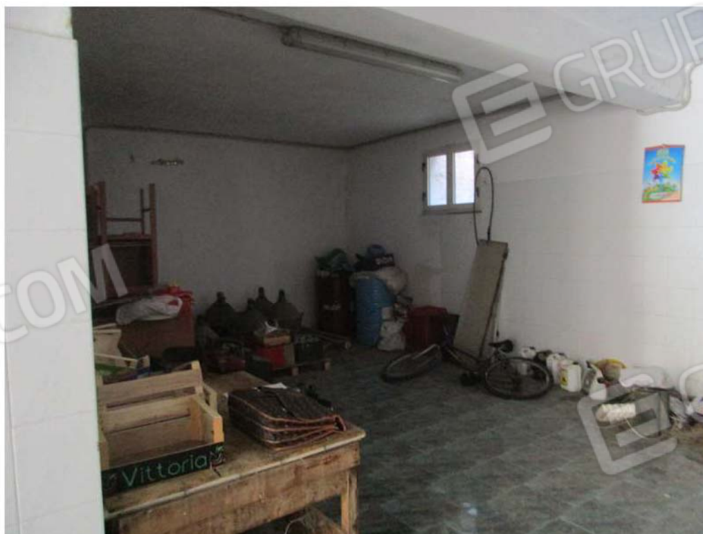
Foto 16: Vista del seminterrato da altra angolazione
