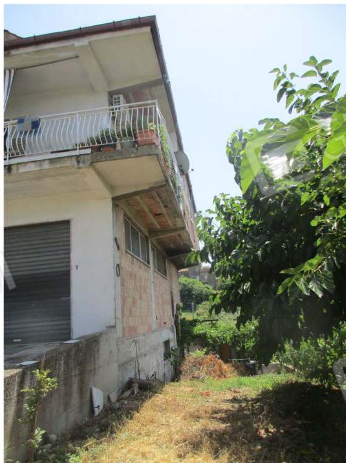
Foto 6: Il fronte Sud del fabbricato
