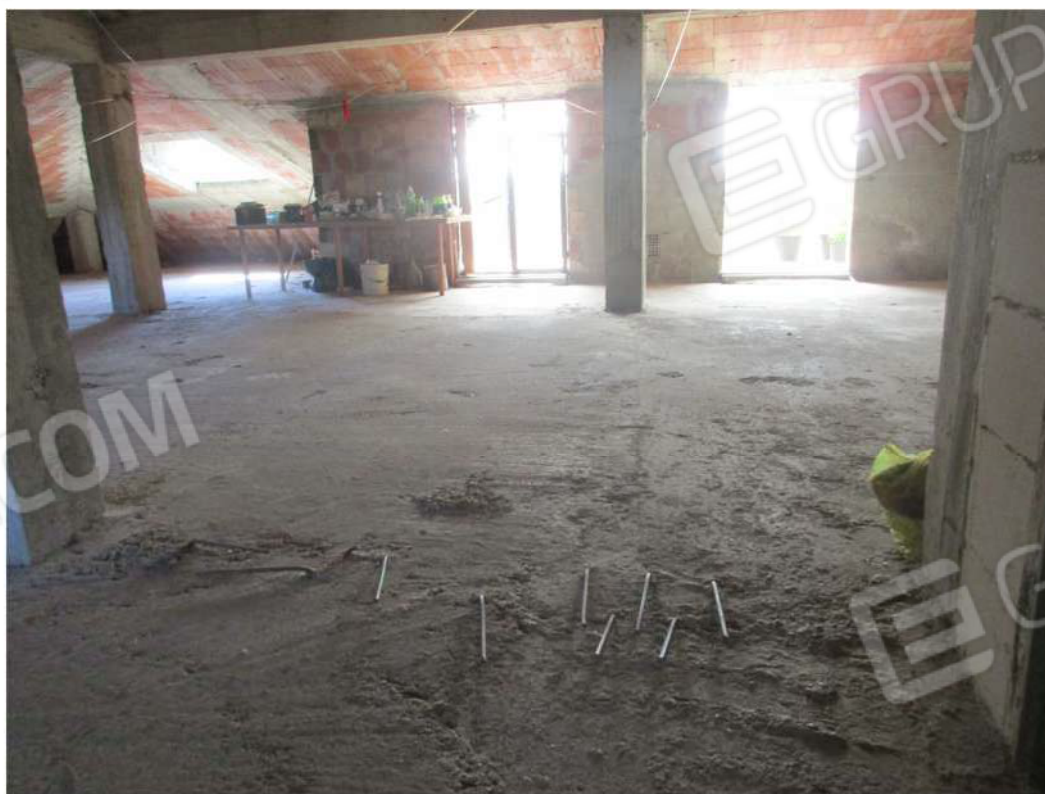
Foto 81: L'interno del sottotetto
