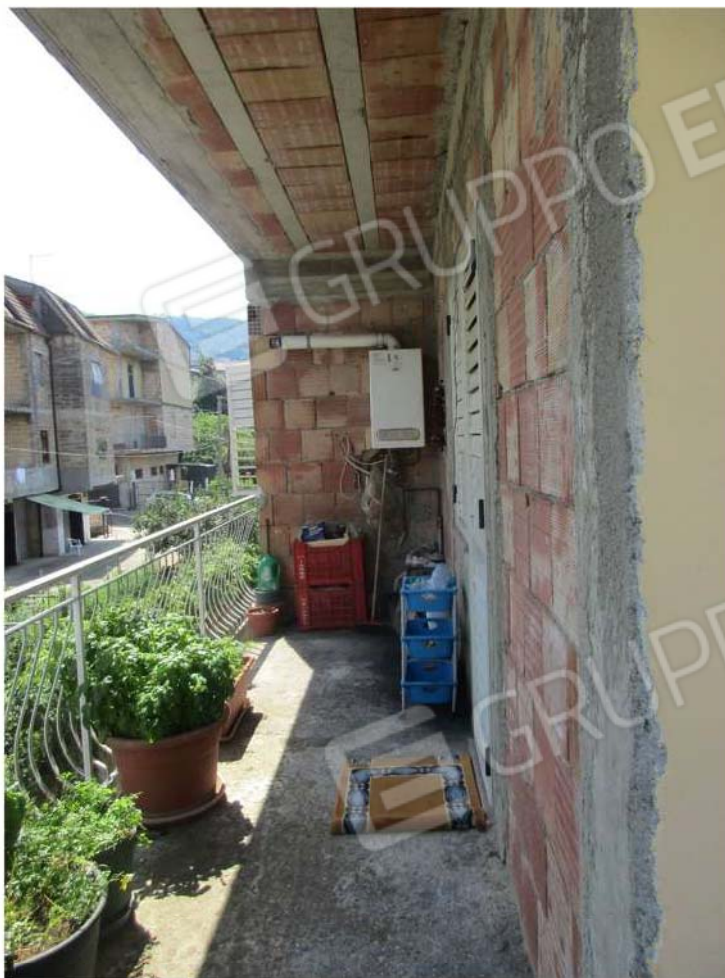
Foto 55: Il balcone sul fronte nord: si noti l'assenza dell'intonaco esterno
