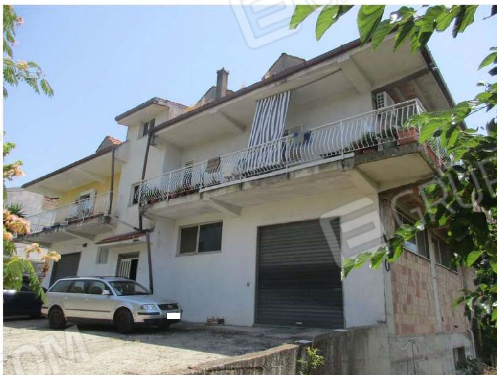
Foto 2: Vista sud ovest del fabbricato
