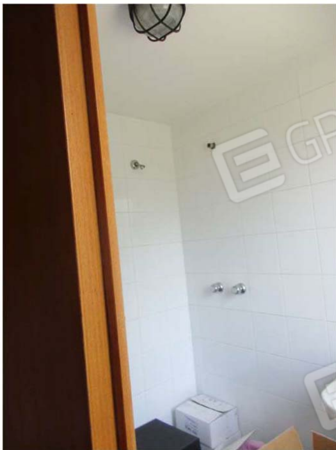
Foto 39: Scorcio del locale doccia
