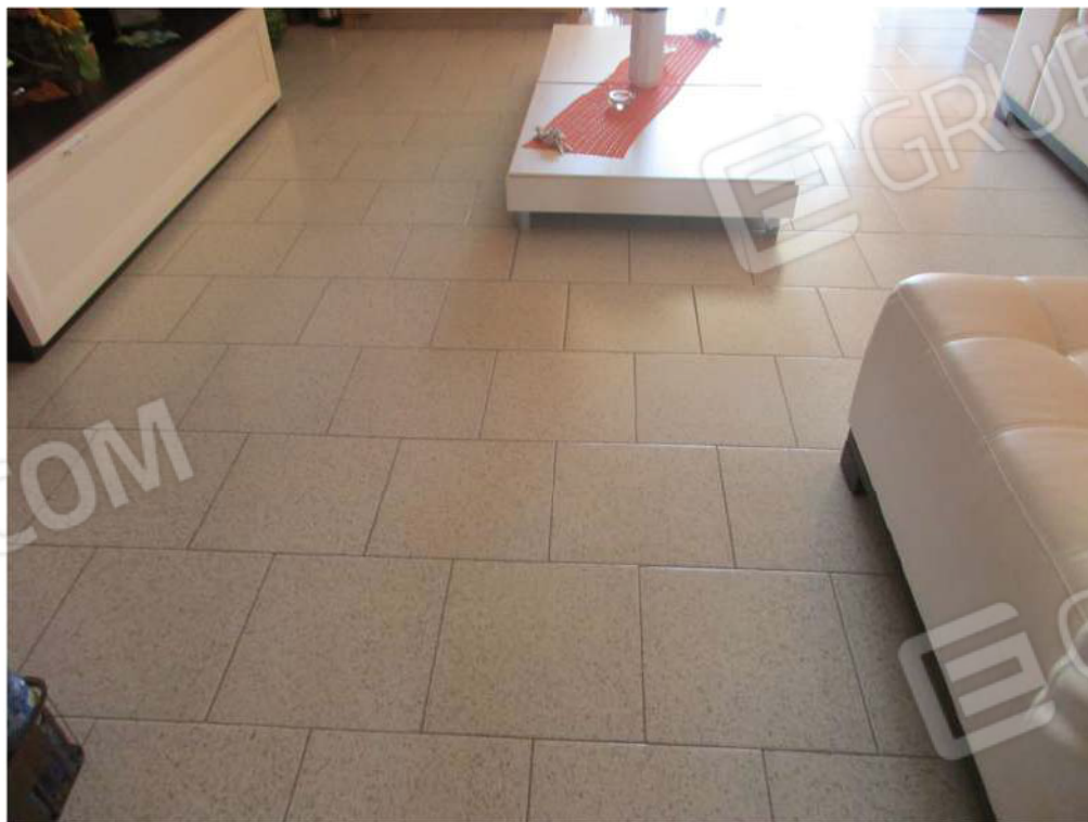
Foto 56: Particolare della pavimentazione del salone
