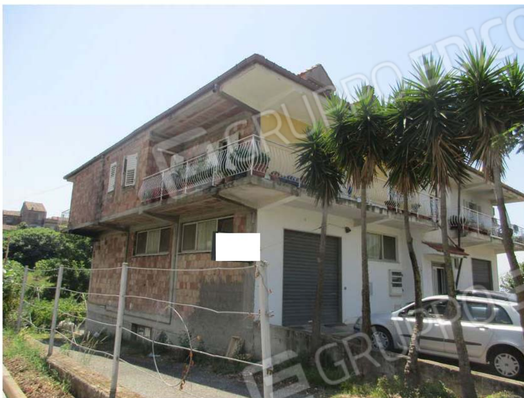
Foto 3: Vista angolo nord-ovest del fabbricato
