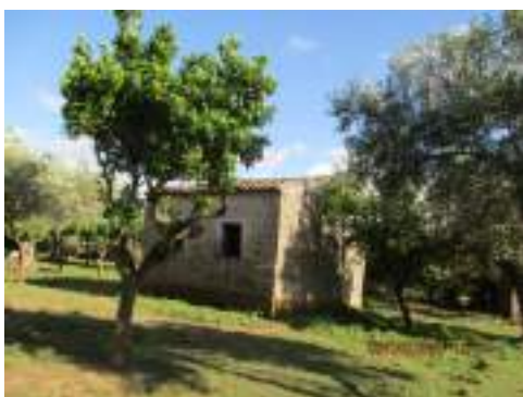
Foto n. 105 – Fabbricato presente sul terreno con la particella 215
