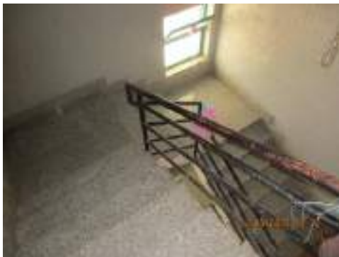
Foto n. 18 – Scala di collegamento
