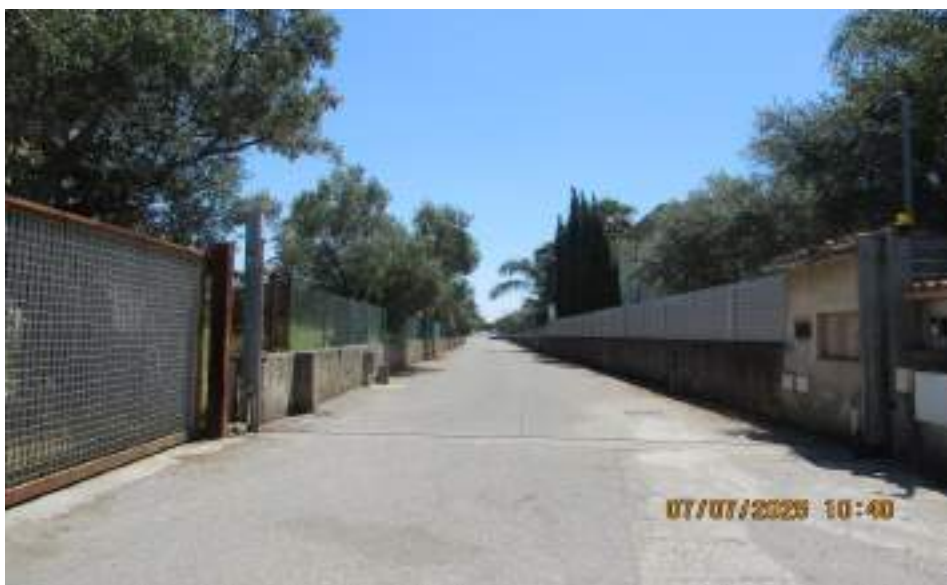
Foto. n. 13 – Strada realizzata sul terreno identificato con la particella n.1189
