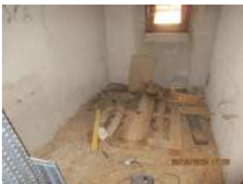
Foto n. 72 – W. C. n. 2
