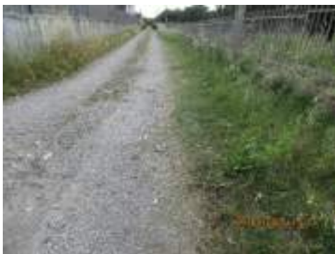
Foto. n. 145- Particolare strada di accesso
