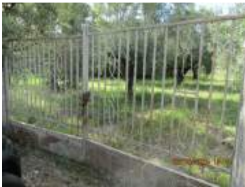
Foto. n. 143- Particolare accesso lato sud
