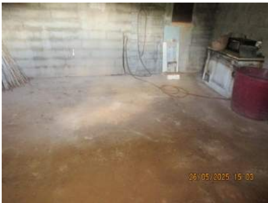
Foto. n. 140- Interno piano terra
