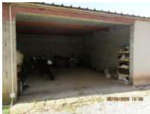
Foto n. 6 – Interno fabbricato n. 2
