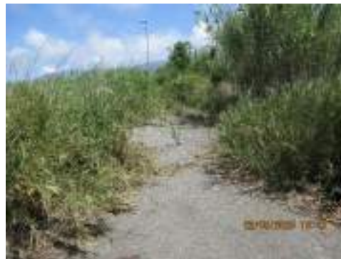
Foto. n. 127 – Strada di accesso
