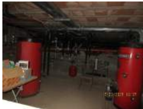
Foto n. 33 – Locale tecnico – Non accatastato
