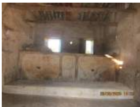
Foto n. 106– Interno fabbricato identificato con la particella 215
