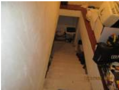
Foto n. 34 – Scala di accesso dal PT
