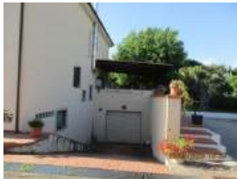
Foto n. 79 – Prospetto sud – Ingresso piano interrato
