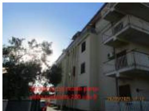
Foto. n. 12 – Area urbana identificata con la particella 230 sub 9
