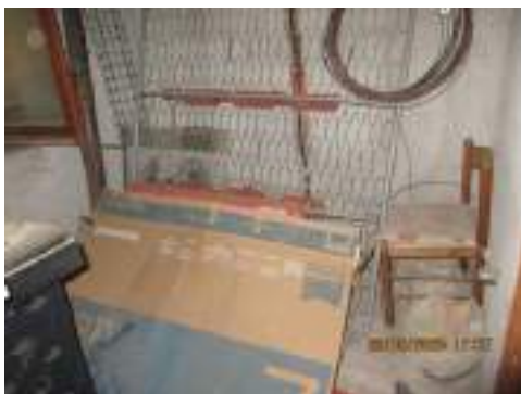
Foto n. 68 – W. C. n. 1
