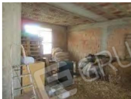
Foto n.º6 Particolare interno
