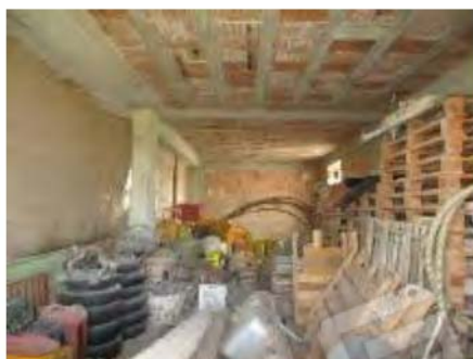
Foto n.º8 Particolare interno
