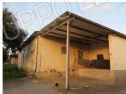
Foto n.º10 Prospetto ovest
