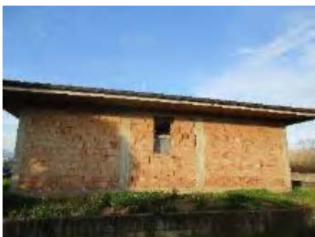
Foto n.º5 Prospetto sud
