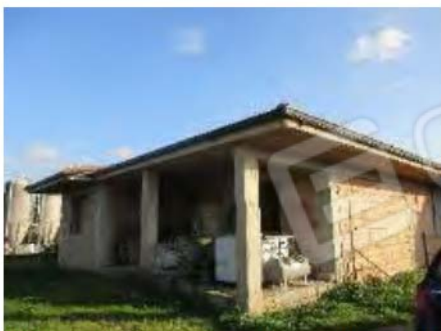
Foto n.º1 – Ingresso – Prospetto nord
