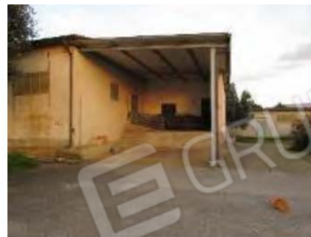
Foto n.º14 Particolare tettoia di accesso
