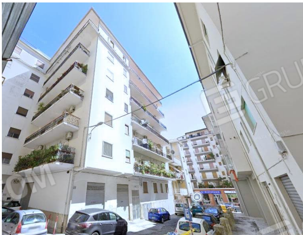
Foto n. 1: Accesso, posto sul prospetto ovest, al fabbricato sito in via Adda del comune di Lamezia Terme, contenente l'unità censita in catasto fabbricati del comune di Lamezia Terme , sezione A al foglio di mappa 20, particella 455, subalterno 25 e 29 (fotografia estratta da Google Street View).
