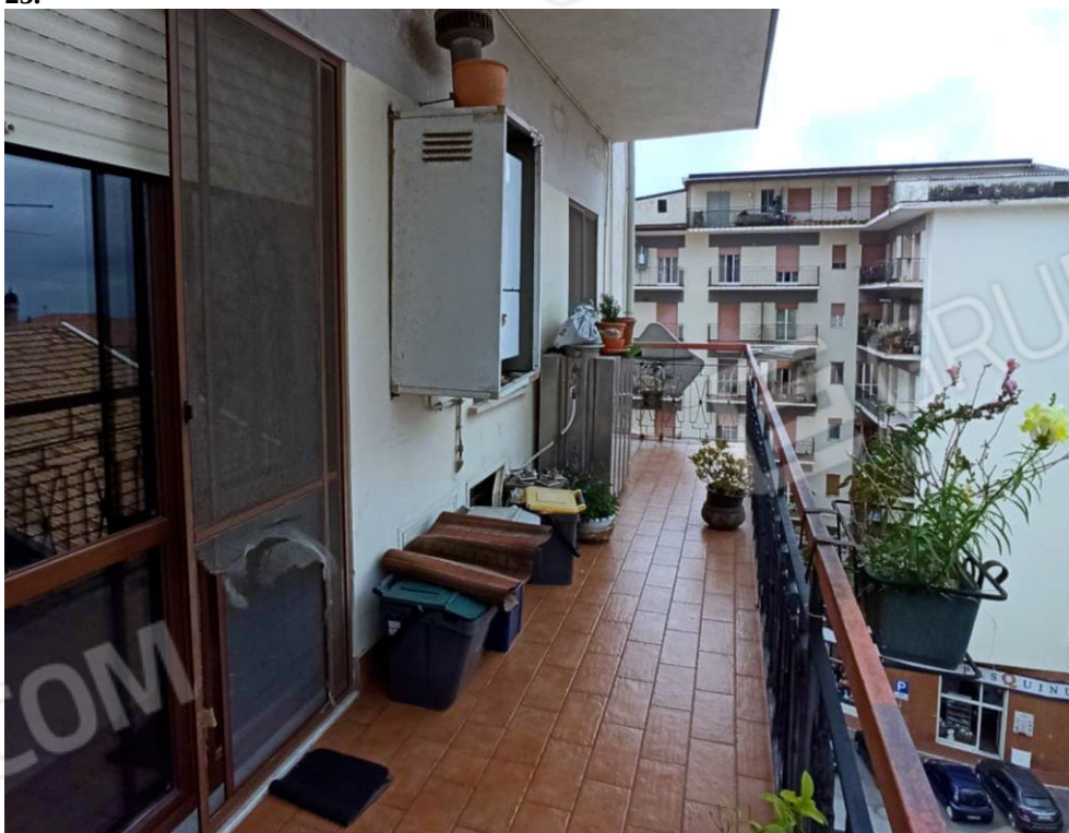
Foto n. 15: Balcone indicato con l'acronimo B2 nella planimetria allegata, relativa all'unità abitativa ubicata al piano quinto del fabbricato censito in catasto fabbricati del comune di Lamezia Terme sezione A al foglio di mappa 20, particella 455, subalterno 25.
