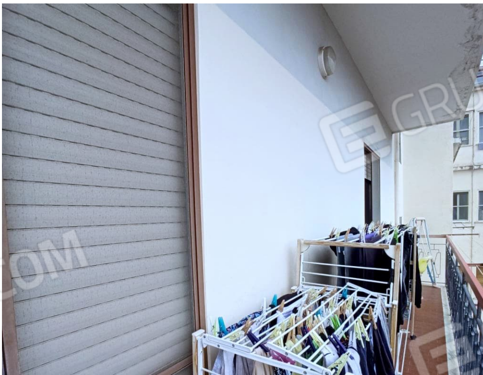
Foto n. 11: Balcone indicato con l'acronimo B1 nella planimetria allegata, relativa all'unità abitativa ubicata al piano quinto del fabbricato censito in catasto fabbricati del comune di Lamezia Terme sezione A al foglio di mappa 20, particella 455, subalterno 25.
