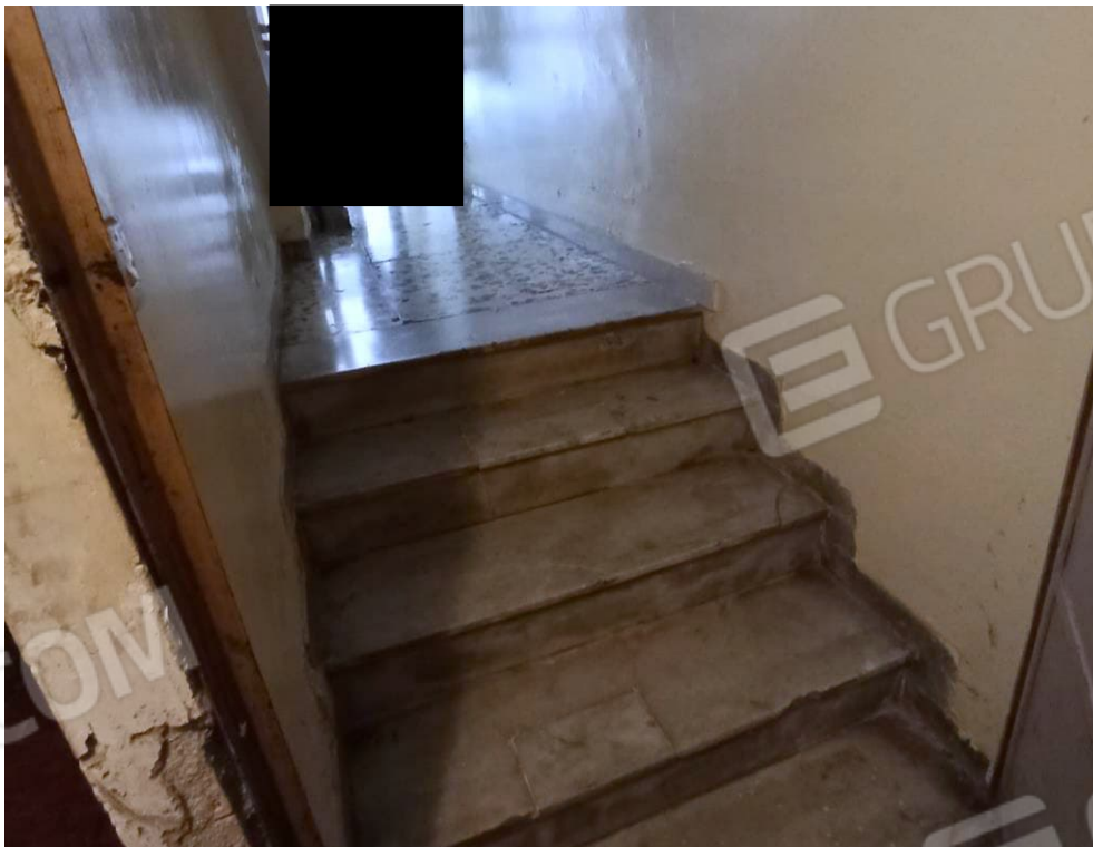
Foto n. 3: Accesso al magazzino seminterrato indicato con l'acronimo M nella planimetria allegata, relativa all'unità abitativa ubicata al piano quinto del fabbricato censito in catasto fabbricati del comune di Lamezia Terme sezione A al foglio di mappa 20, particella 455, 29.
