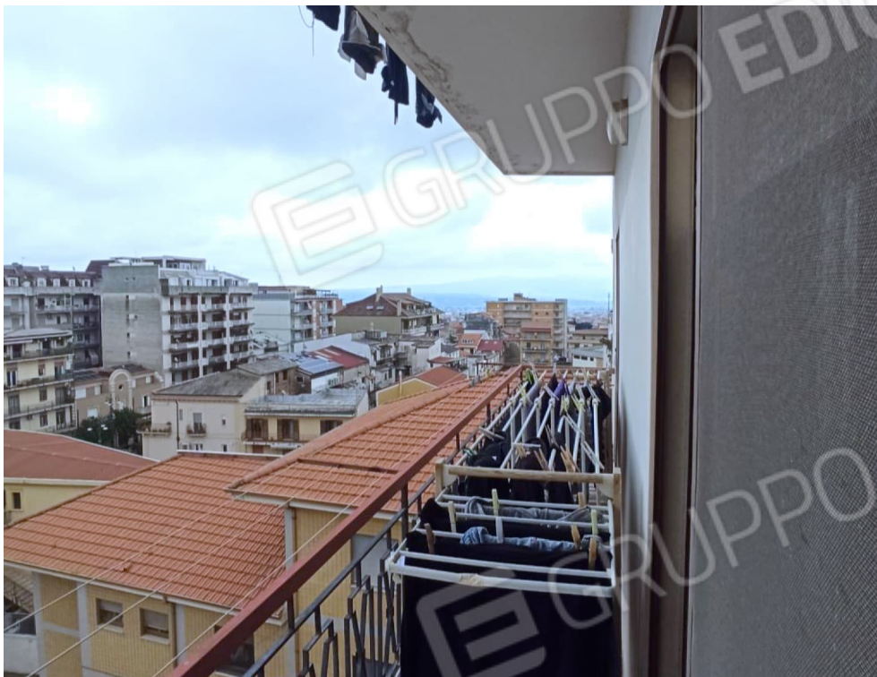
Foto n. 10: Balcone indicato con l'acronimo B1 nella planimetria allegata, relativa all'unità abitativa ubicata al piano quinto del fabbricato censito in catasto fabbricati del comune di Lamezia Terme sezione A al foglio di mappa 20, particella 455, subalterno 25.
