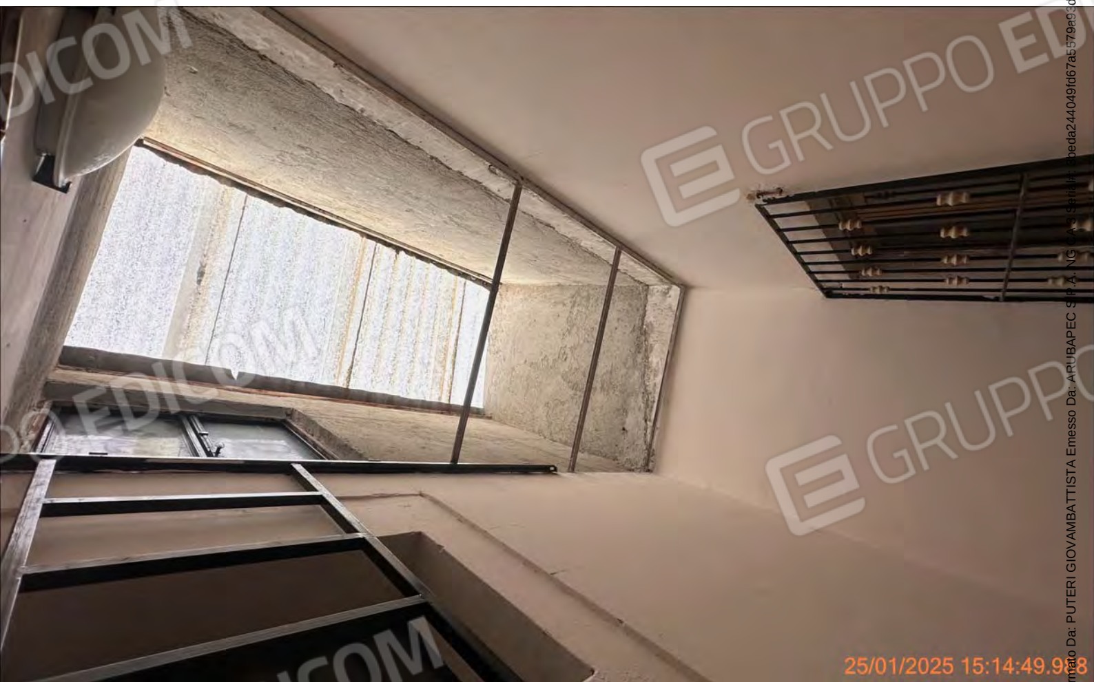
4 lucernaio vano scala.jpg
