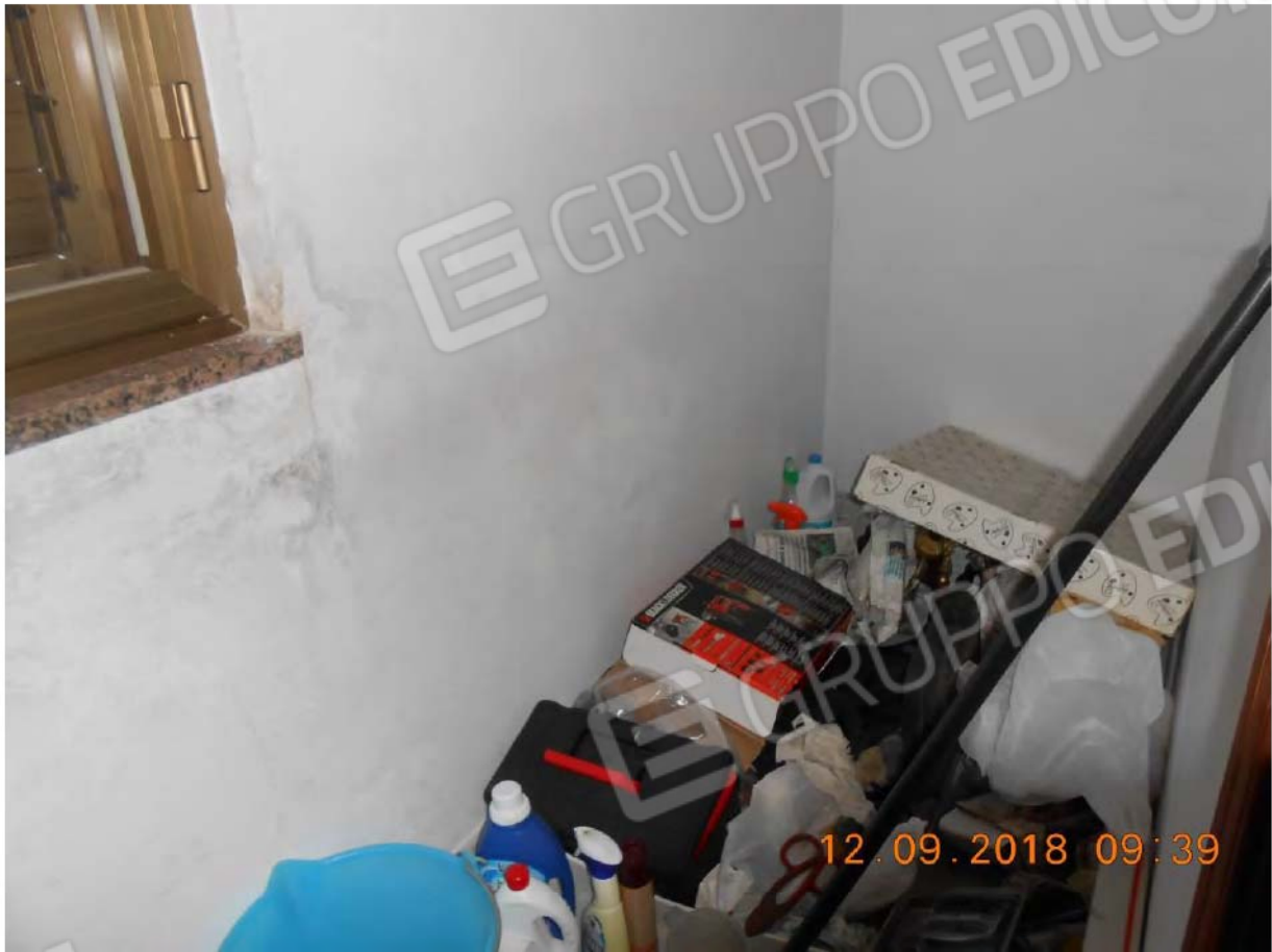
Foto 19. Ripostiglio – piano primo
